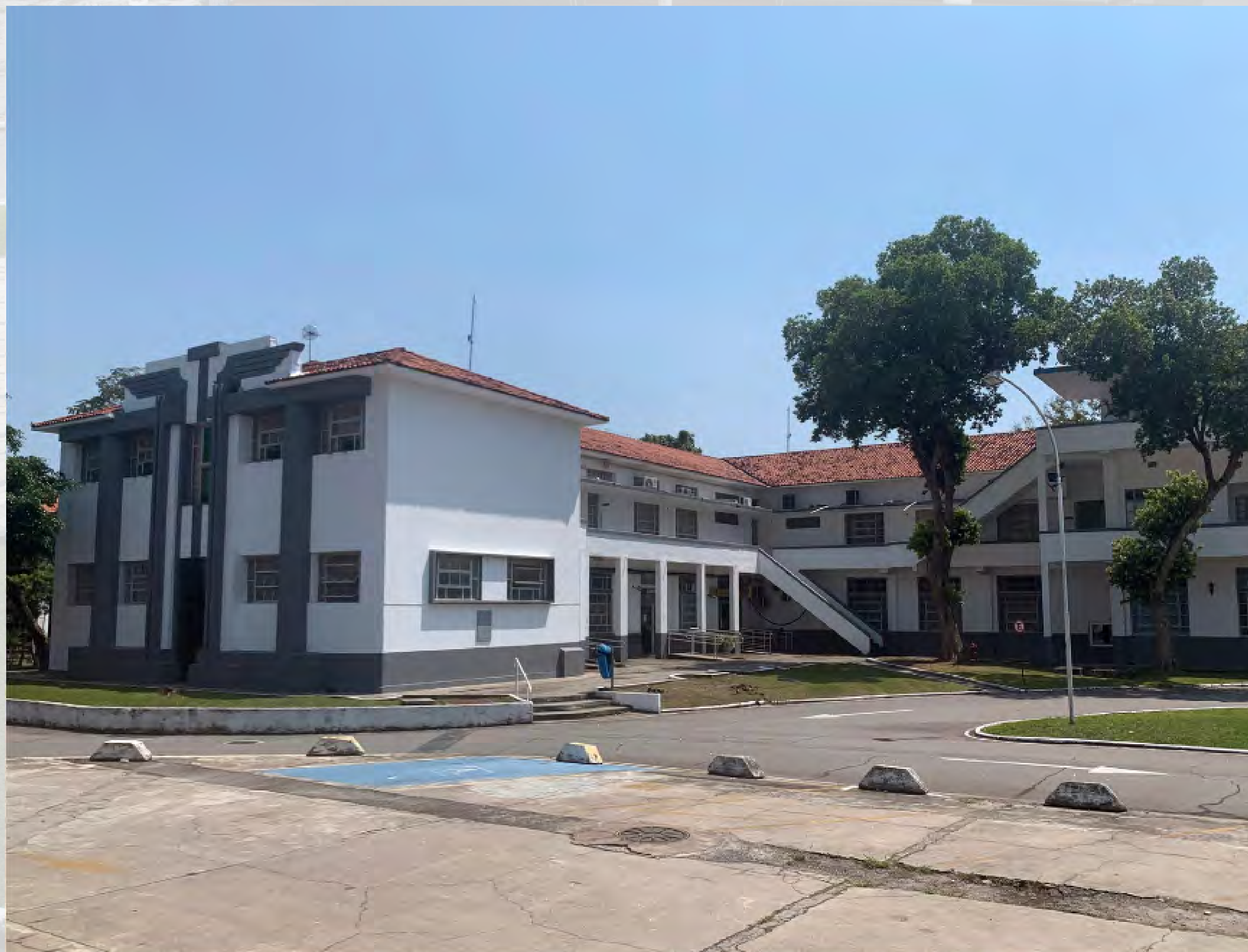
Foto: Fundos do prédio do Comando da UNIFA, em 2021. Detalhe para a simetria dos detalhes no anexo, as escadas externas e os basculantes utilizados, características do Art Déco. Acervo: CMel
