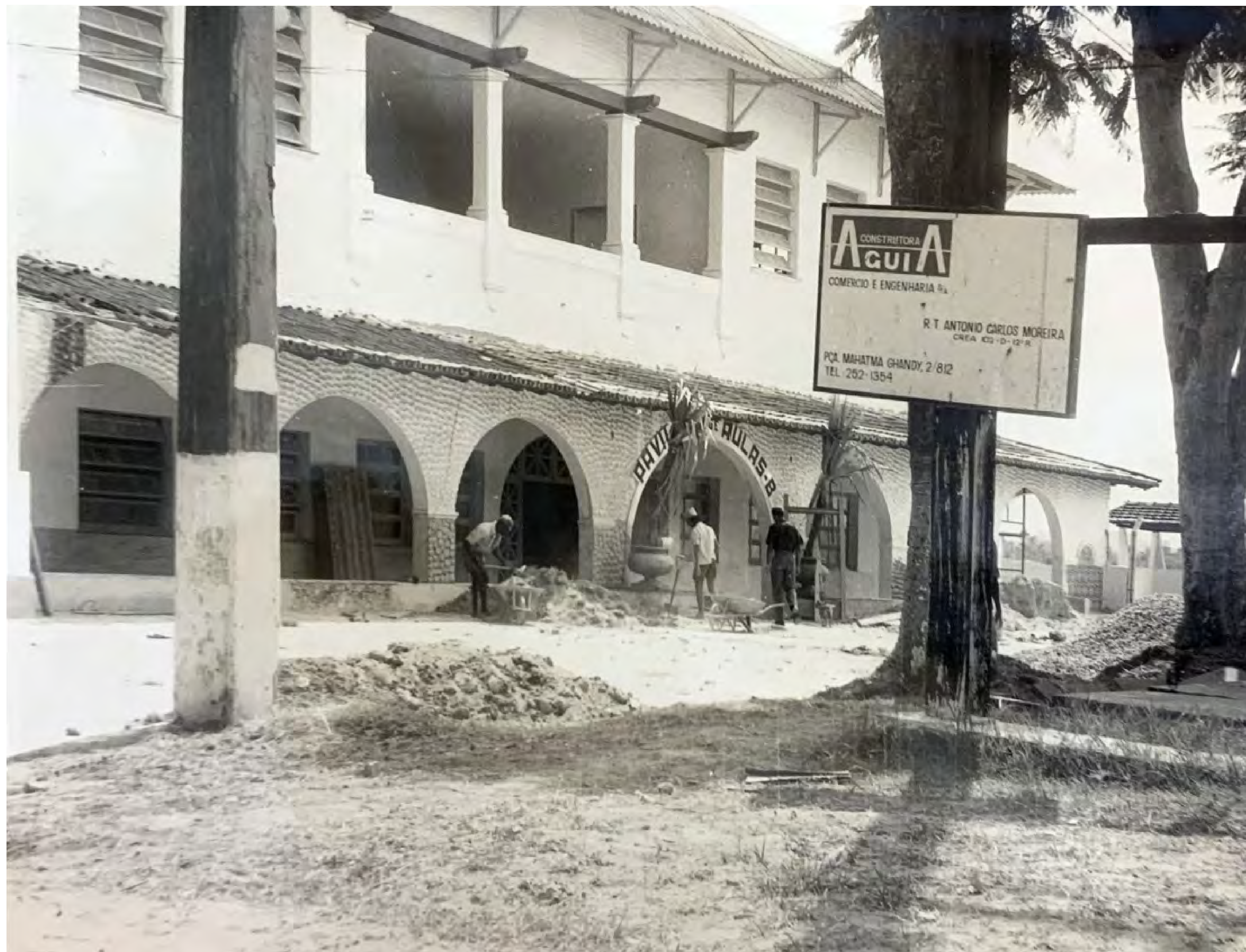
Foto: Fachada do prédio utilizado pela Escola de Aeronáutica, na década de 1970, para aulas. Seu estilo neocolonial apresenta fachada de argamassa rústica, varandas em arco, balcões e beiradas largas, janelas de madeira, faixas em relevo, pedras na fachada, ânforas e azulejos. Fonte: CENDOC
