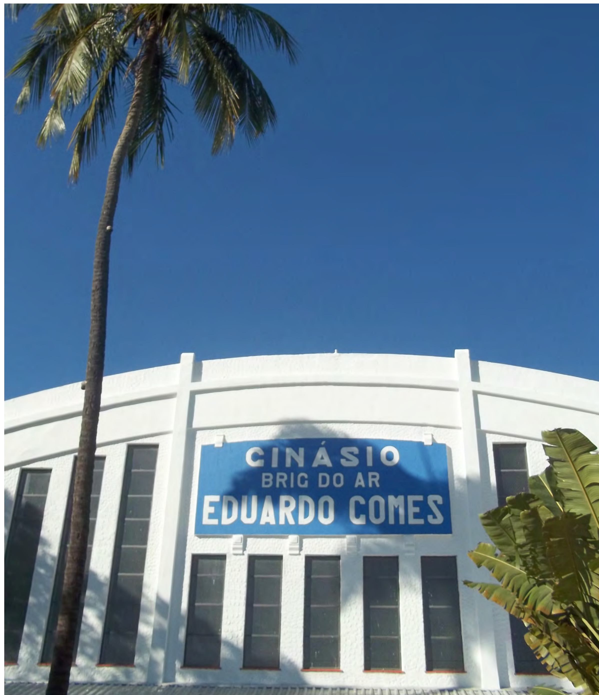
Foto: Fachada do Ginásio Brigadeiro do Ar Eduardo Gomes. Detalhe para as faixas paralelas em alto relevo, horizontais. Fonte: CMel
