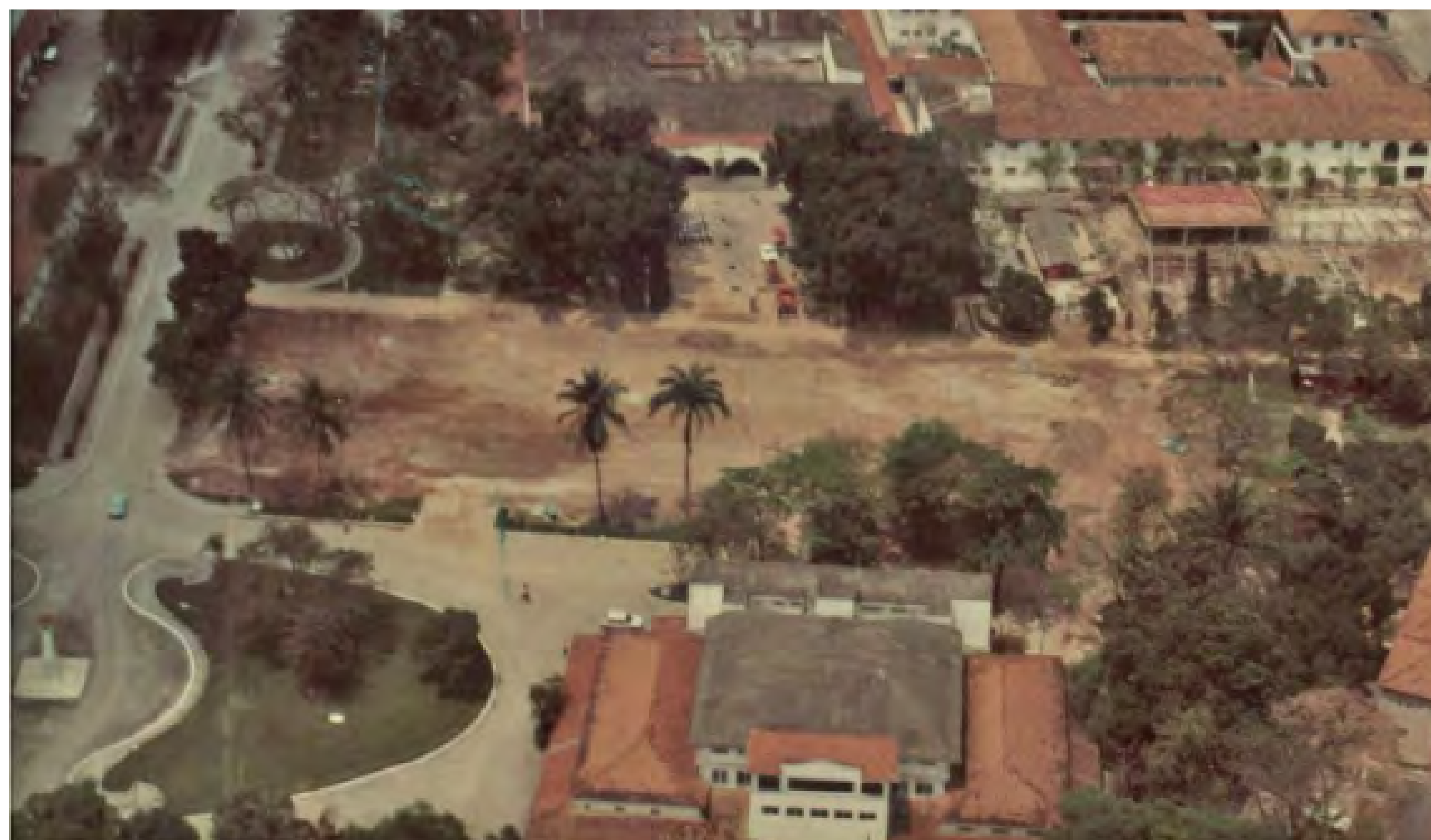
Foto: Vista aérea após a demolição do Pavilhão, em 1983. Acervo: CMel
