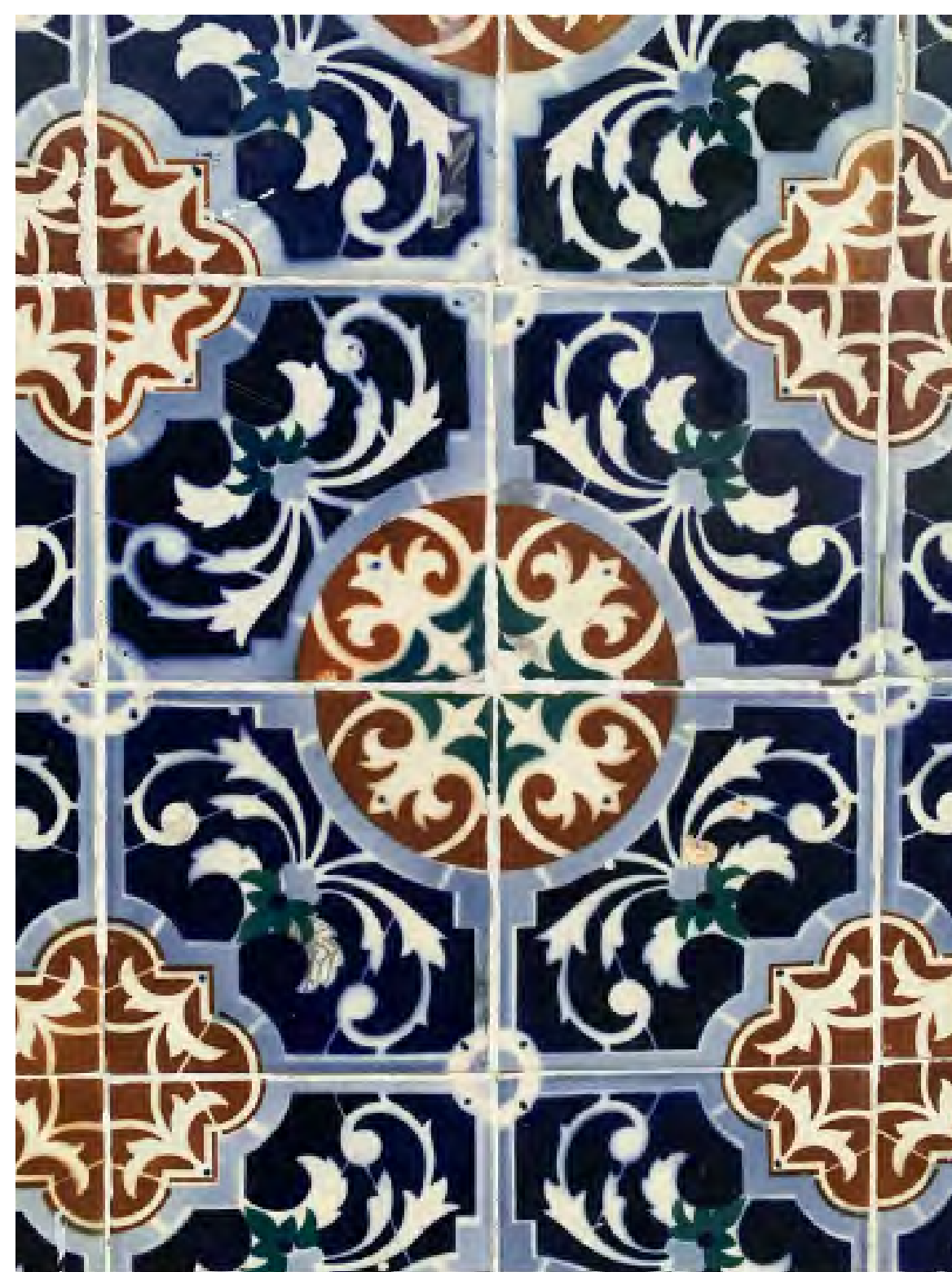
Foto: Azulejos estilo português, assentados no banco que se encontra na fachada do prédio. Ornamentação muito utilizada no estilo neocolonial. Acervo: CMel
