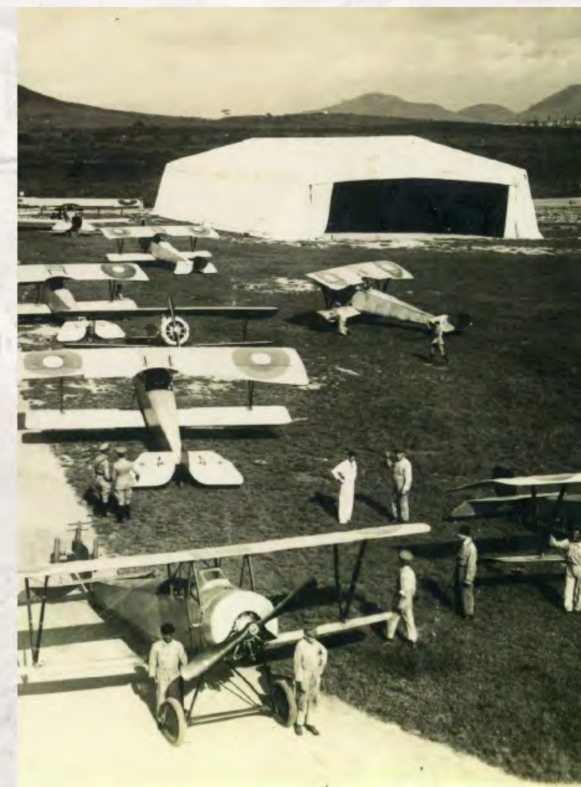
Foto: Construídos de lona e madeira, os hangares ou tendas Bessonneau foram amplamente utilizados pelas aviações francesa e inglesa durante a Primeira Grande Guerra. No Brasil, os hangares foram construídos no início da década de 1920, no Campo dos Afonsos, para abrigarem, temporariamente, aeronaves e material oriundos da França. Fonte: MUSAL
