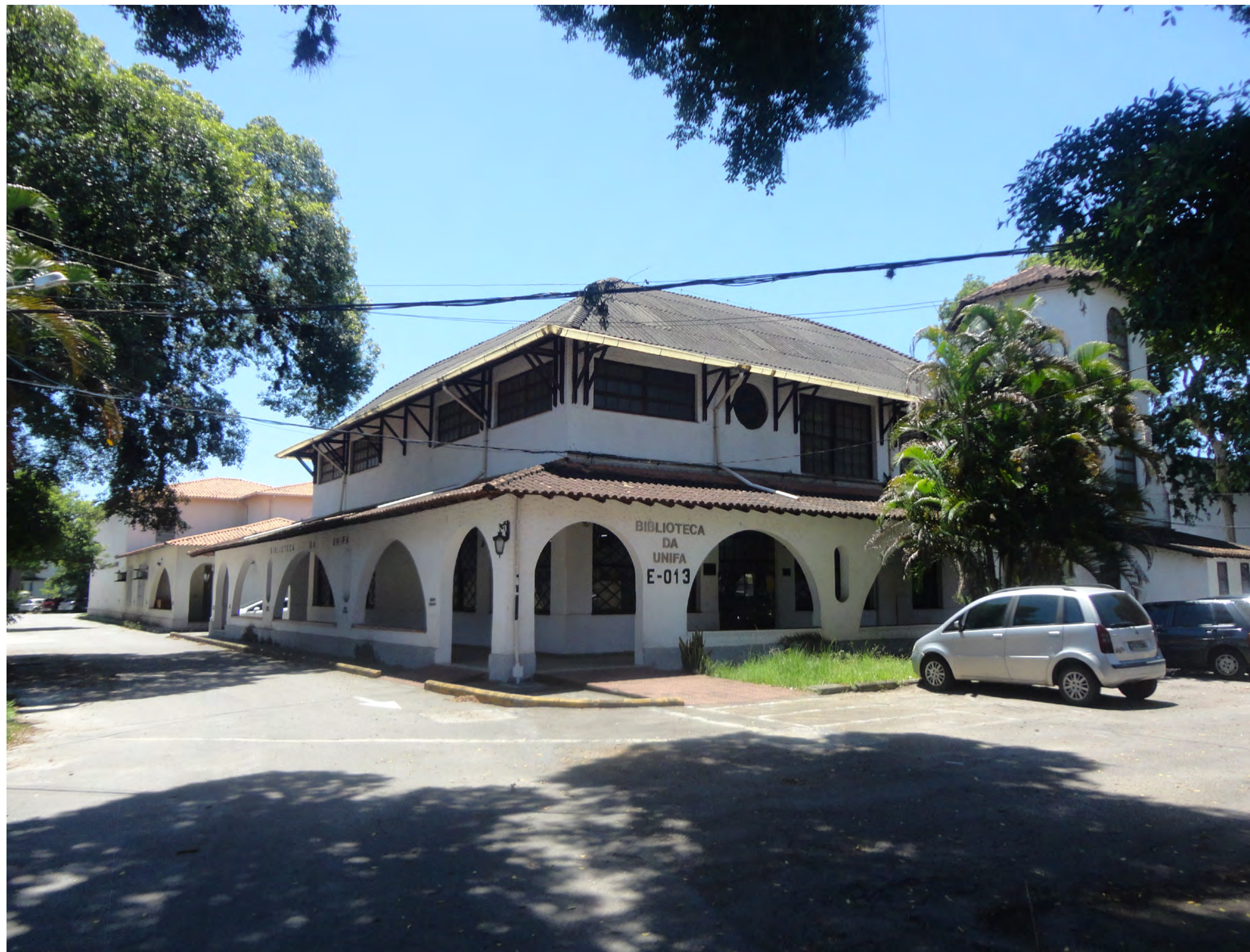
Foto: Fachada e lateral da Biblioteca, detalhe do estilo neocolonial nas varandas em arco, claraboia com vitral, janelas do 1º andar em vidro e madeira com rótulas, beirais largos, luminárias externas em ferro fundido e revestimento rústico com reboco em relevo. Acervo: CMeI
