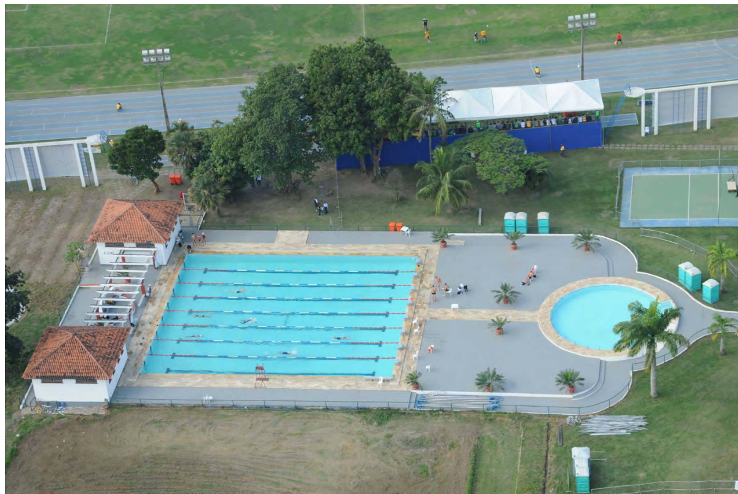
Fotos: Vista aérea da piscina. Detalhes do chafariz estilo neocolonial, painel de azulejo, ânforas, vigas de madeira formando um pergolado, beira larga. Fonte: CMel
