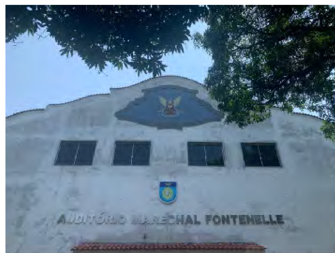
Foto: Detalhes da fachada do Auditório Marechal Fontenelle do símbolo da Escola de Aeronáutica. Acervo: CMel
