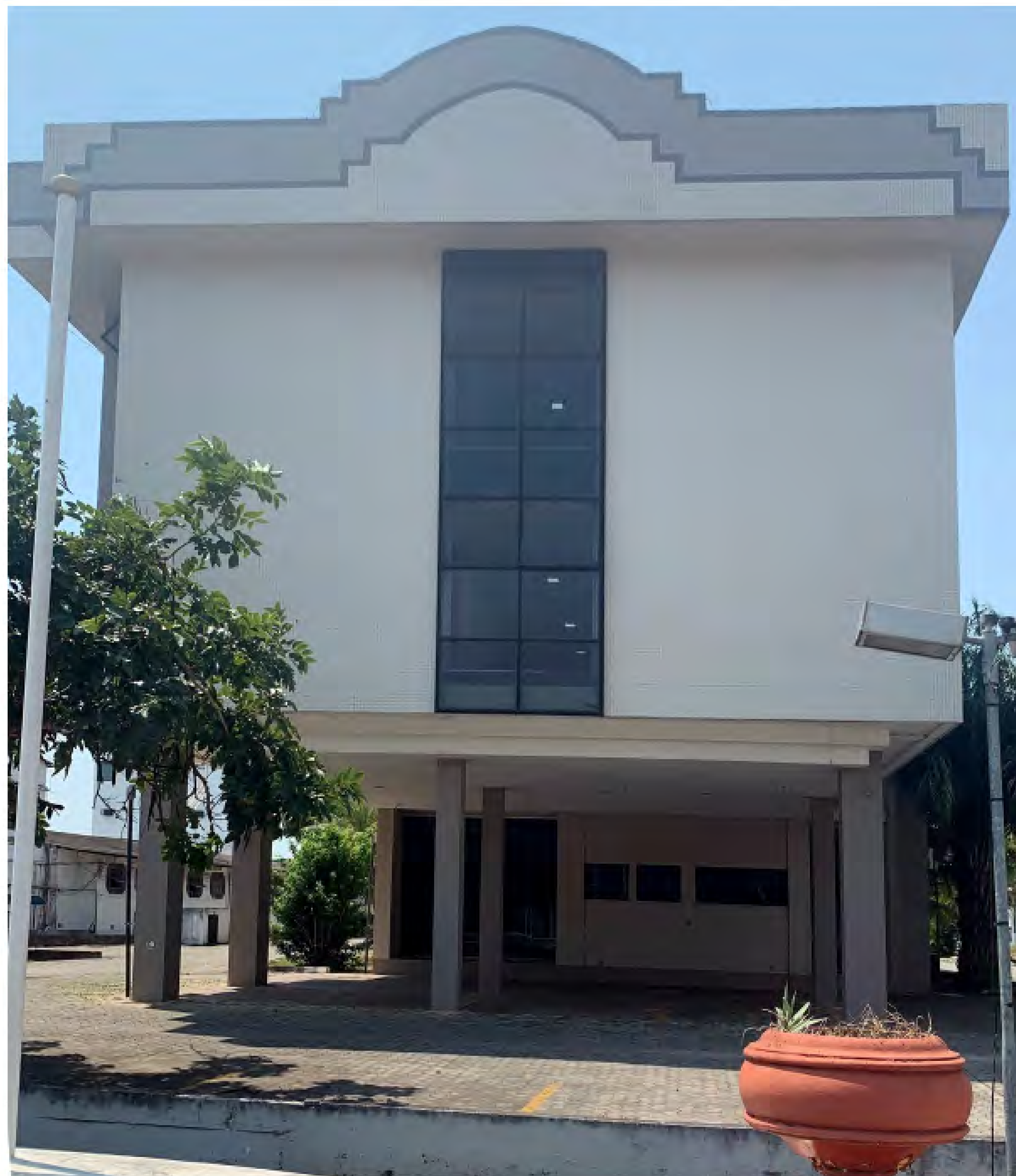
Foto: Lateral do prédio do Hotel de Trânsito dos Oficiais. Acervo: CMel
