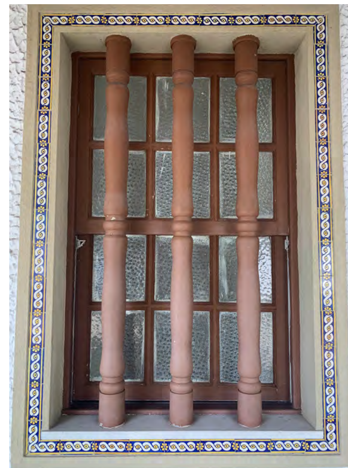
Fotos: detalhes da área externa da Capela N. S. do Loreto com destaque para a varanda com estilo eclético, para os azulejos assentados nos portais com acabamento em cimento, janelas com grades de madeira torneadas. Acervo: CMel
