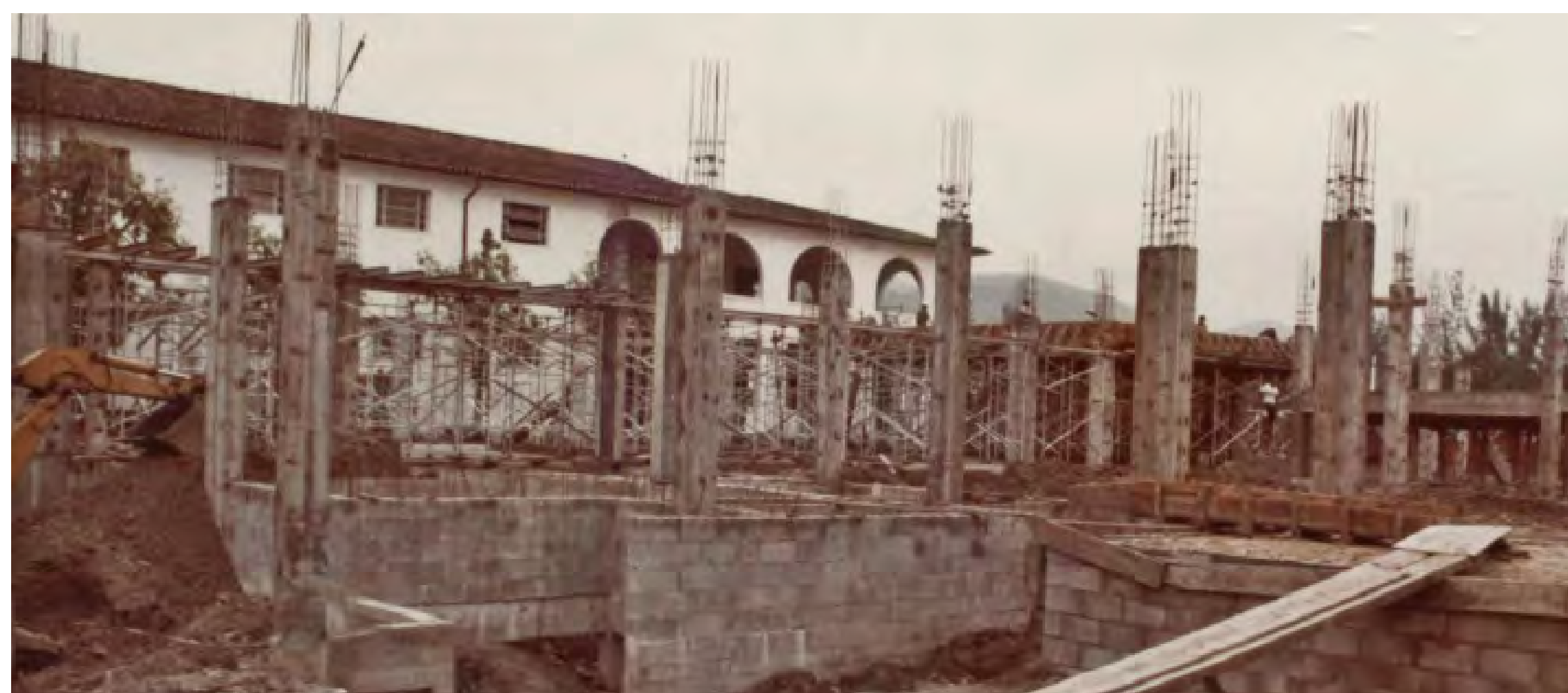
Fotos: Construção da fundação do prédio da EAOAR, em 1983. Acervo: CMel
