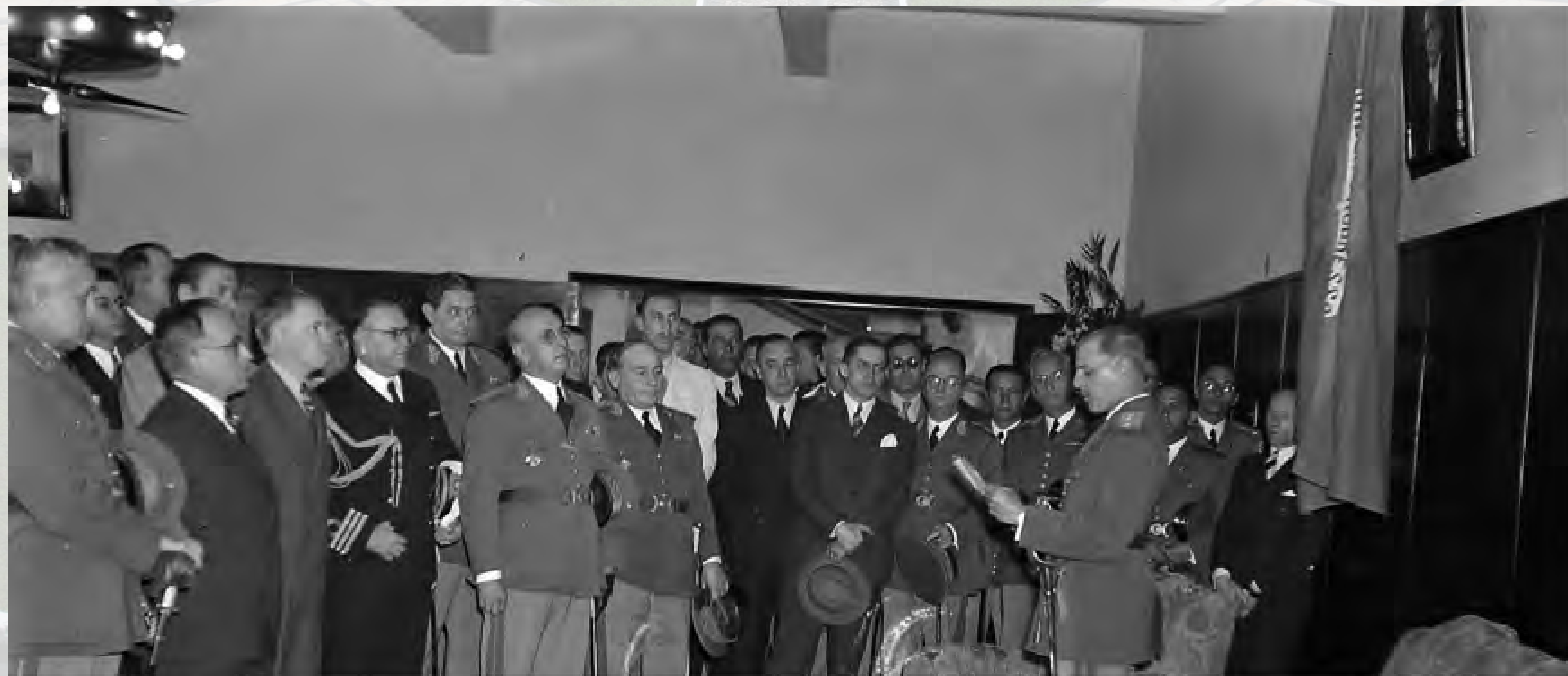
Foto: Visita do presidente Getúlio Vargas. Detalhe para o revestimento da parede, reconstruído em 2018. Ano 1940. Fonte: Arquivo Nacional
