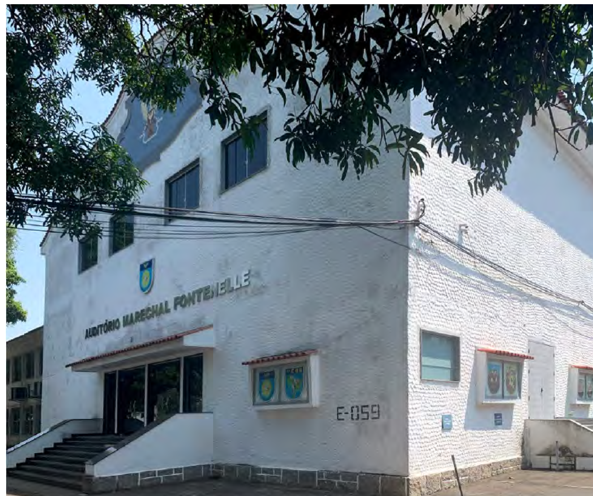
Foto: Fachada e lateral do prédio, pode-se observar uma das saídas laterais, a porta blindada de vidro. A edificação possui características do estilo neocolonial com revestimento rústico, com reboco em relevo e barra de pedras. Acervo: CMel
