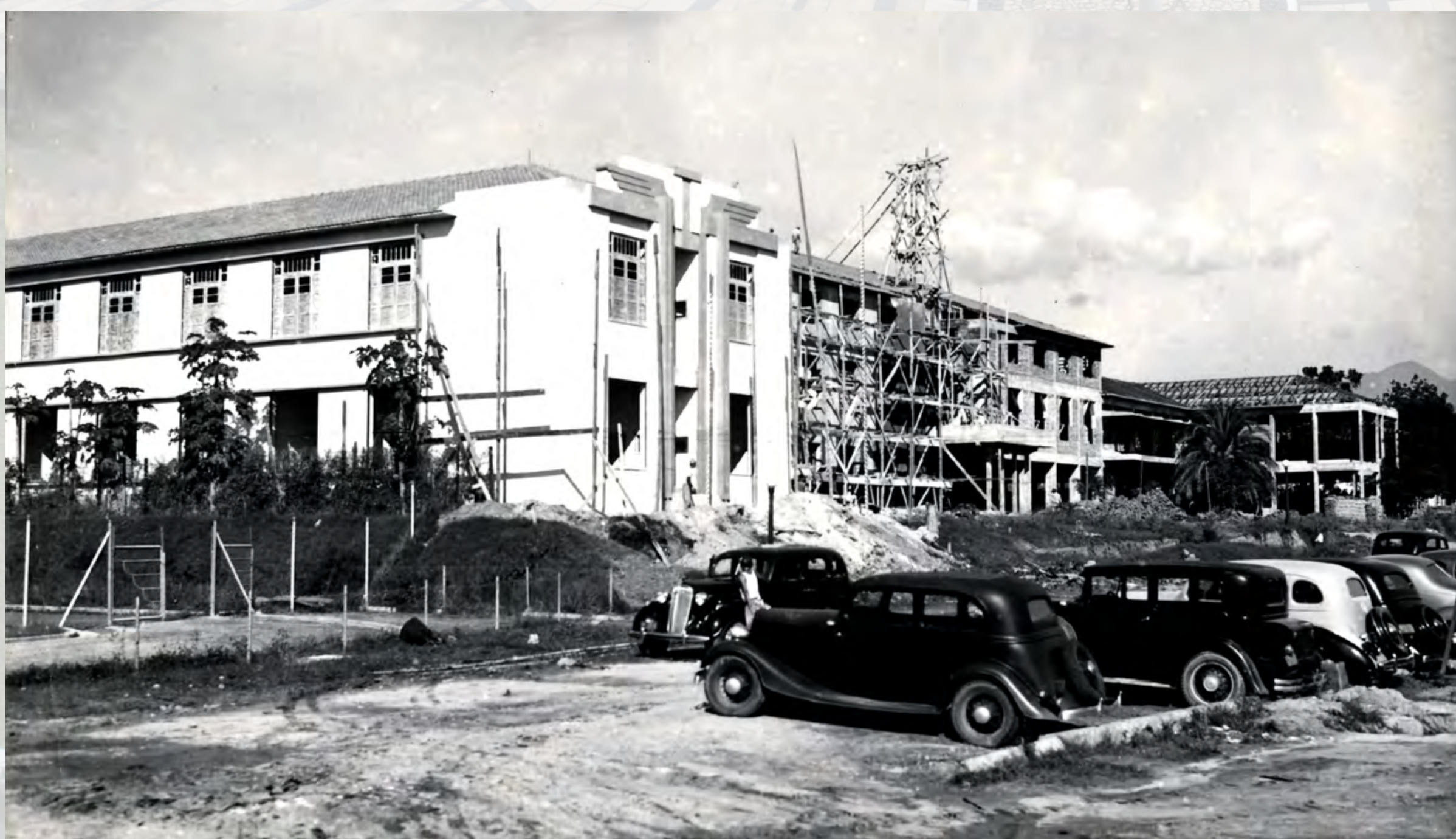
Foto: Construção do prédio do atual comando UNIFA. Destaque para o início da construção do Sabre alado Ano 1938. Fonte: MUSAL
