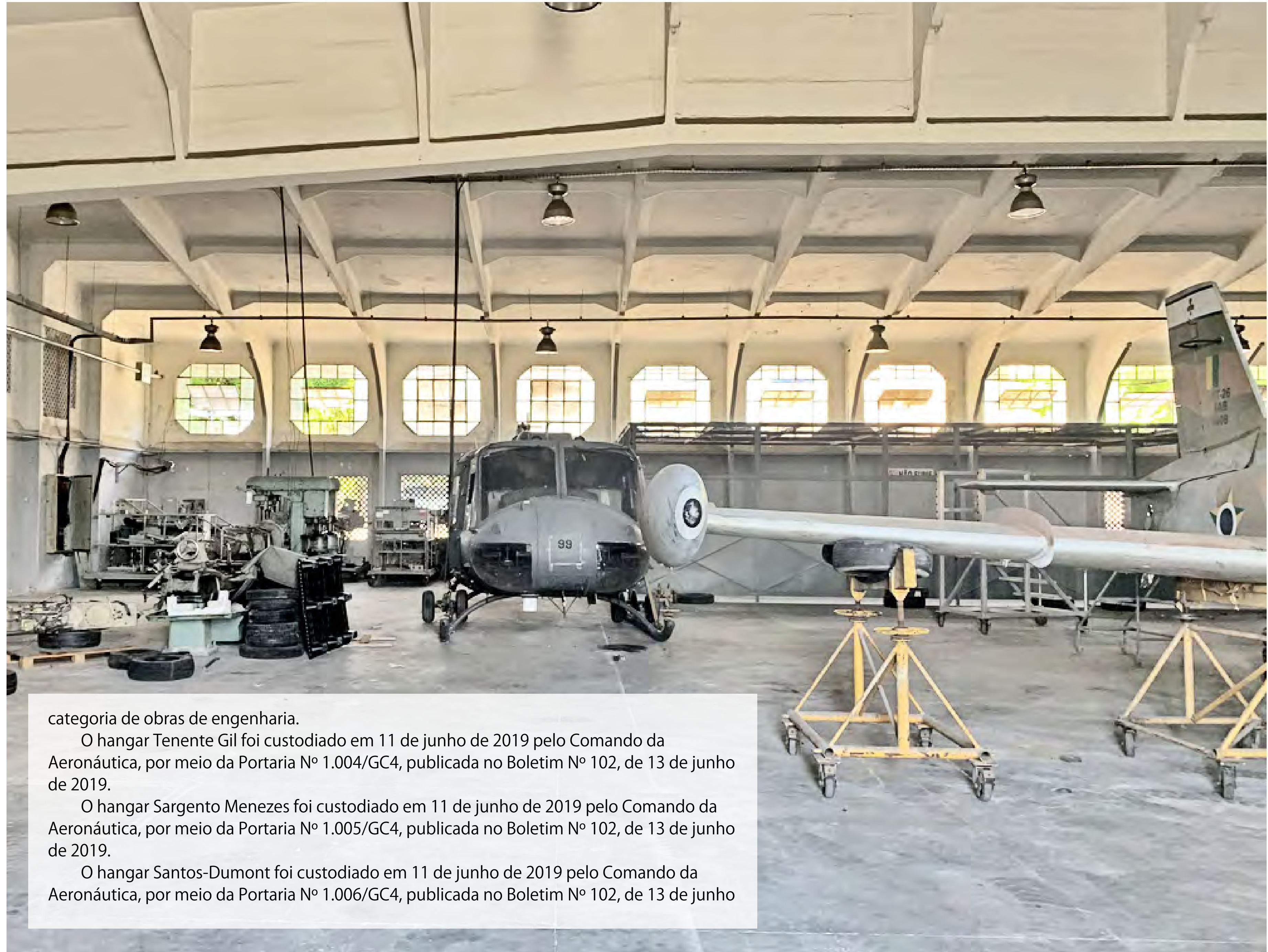
Foto: Interior do hangar de cimento armado, construído no início da década de 1920. O hangar possui características do Art Déco, como os basculantes em forma de óculos. Fonte: CMel
