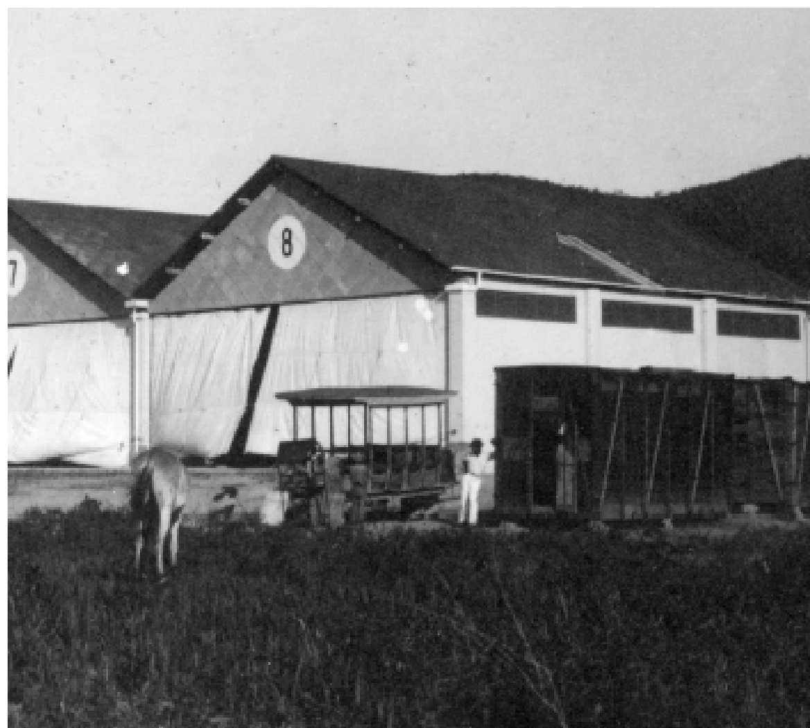
Foto: Vista parcial do Hangar 8, próximo ao ponto de parada do bonde de tração animal. Fonte: MUSAL
