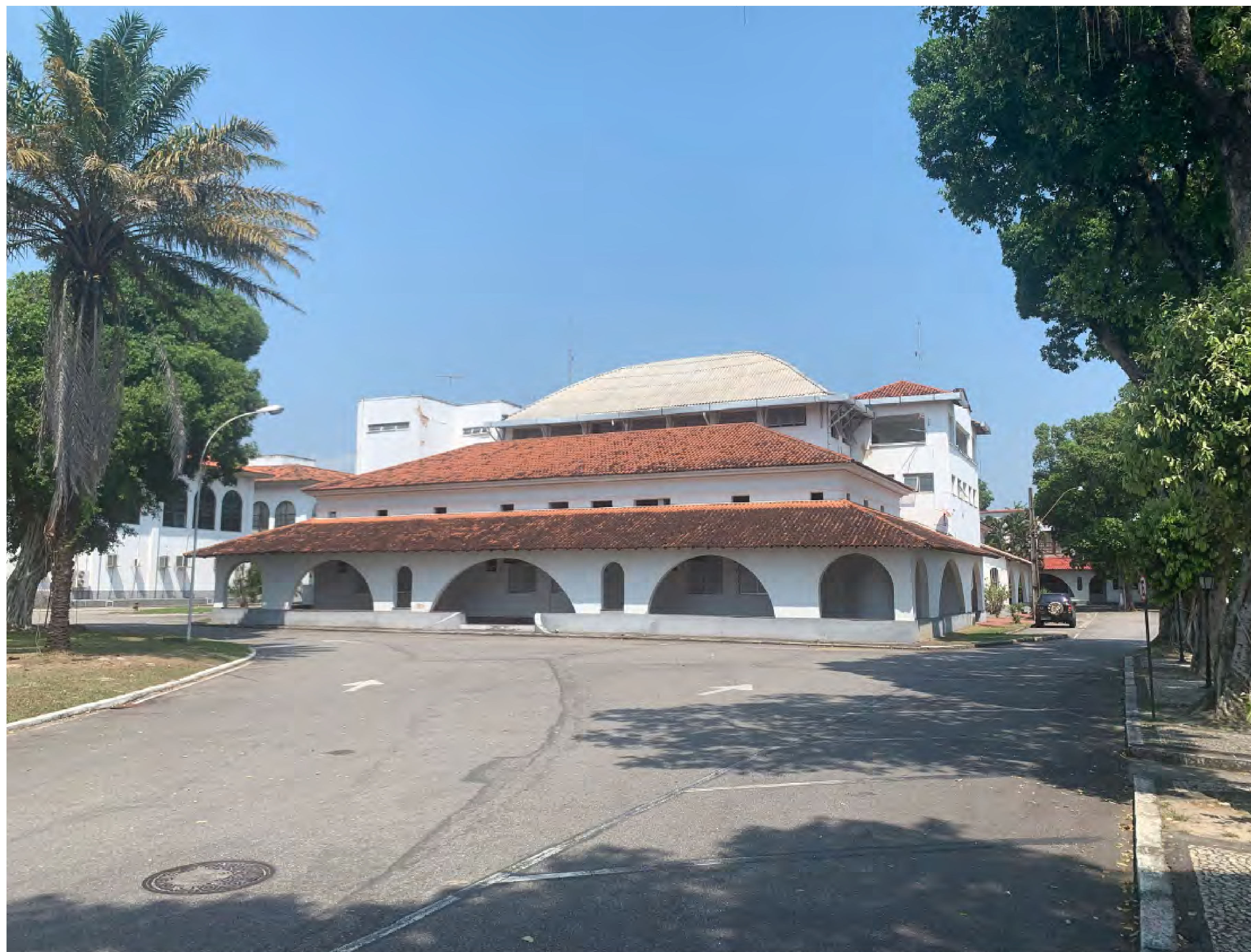
Foto: Alojamento em 2021. Detalhe para as varandas em arco e frisos. Em estilo eclético, o prédio recebeu diferentes alterações arquitetônicas ao longo dos anos. Acervo: CMel
