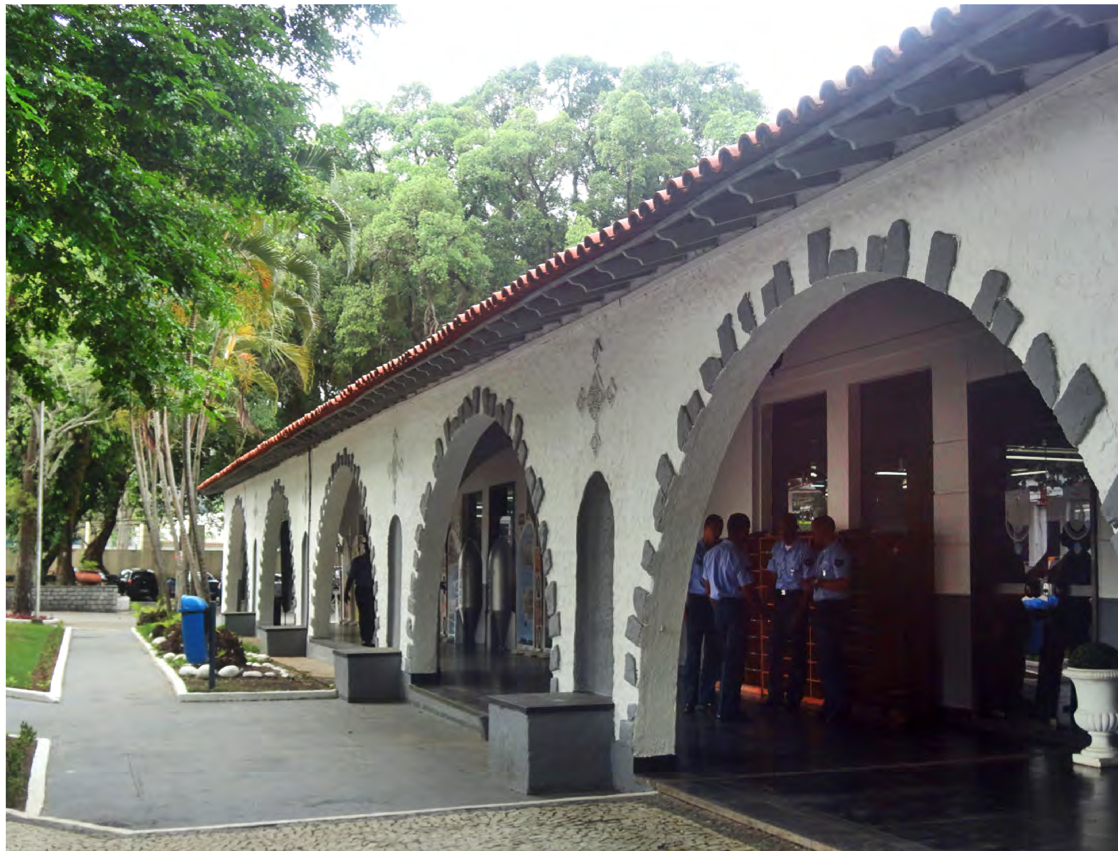
Foto: Detalhe da varanda em arco que compunha a fachada do rancho em 2015. Acervo: CMel
