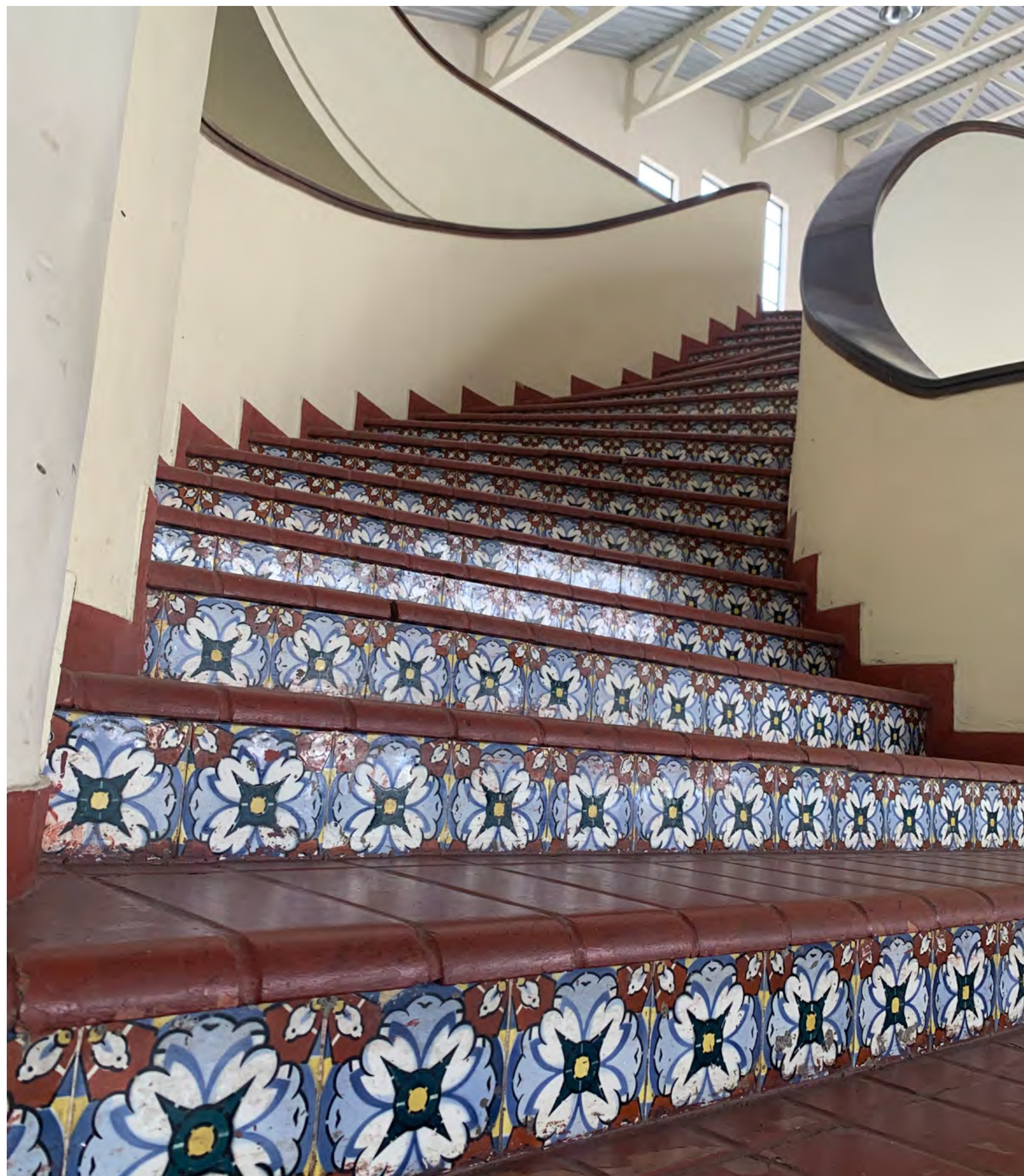
Foto: Escada no Ginásio Brigadeiro do Ar Eduardo Gomes. Detalhe para o revestimento neocolonial, com azulejos nos espelhos da escada. Fonte: CMel .
