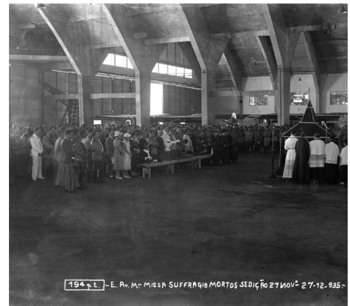
Fotos: Início da fundação do "Hangar Duplo", o Hangar pronto e detalhe do interior com colunas e vigas aparentes na missa aos mortos do levante de 1935. Fonte: MUSAL
