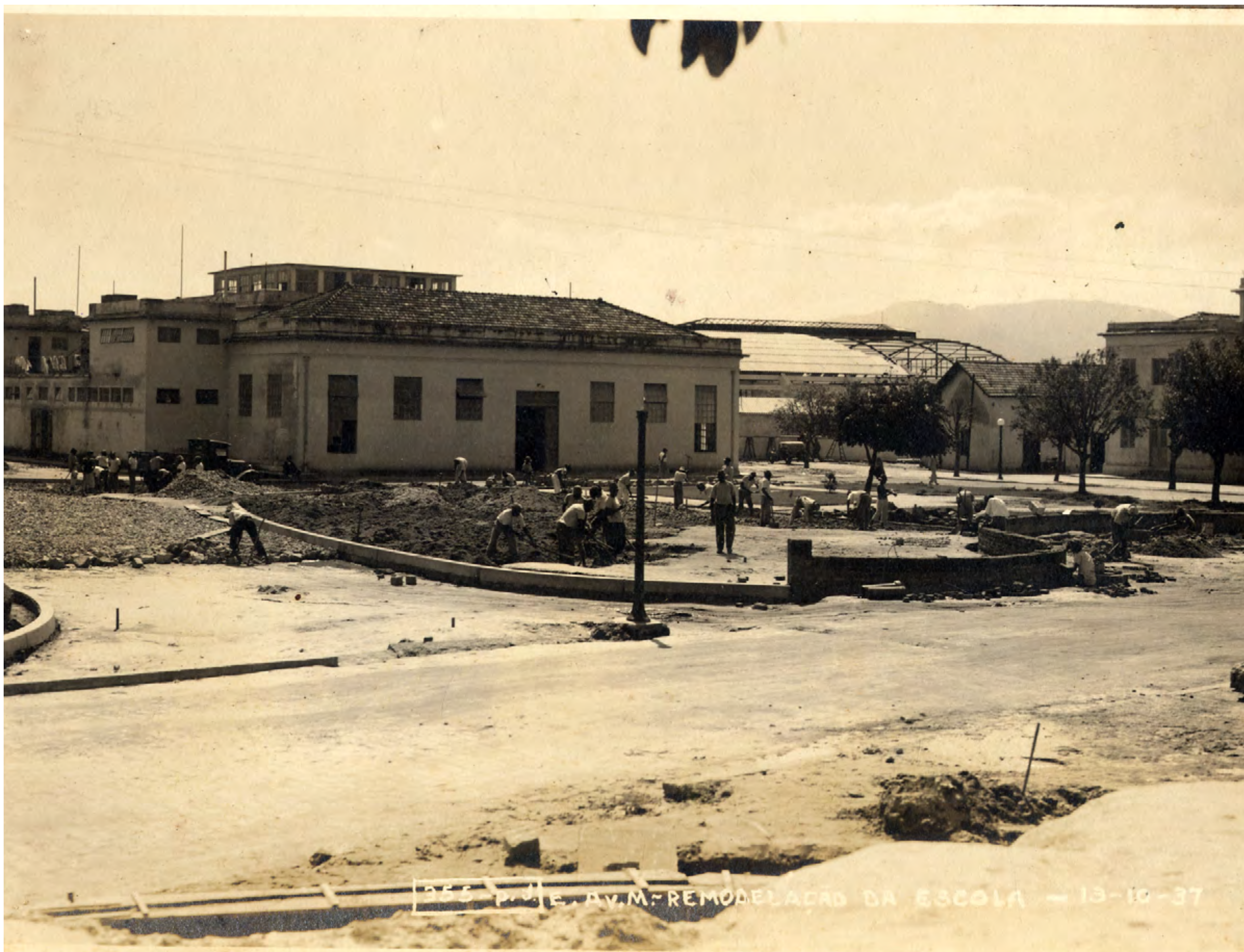
Fotos: Diversos períodos: - construção da praça, 1937; - demolição do antigo Corpo da Guarda da Escola para a construção da Praça, em 1938; - praça durante a remodelação, em 1939; - praça com o monumento “Ícaro e Dédalo” ao centro, em 1942. Fonte: MUSAL
