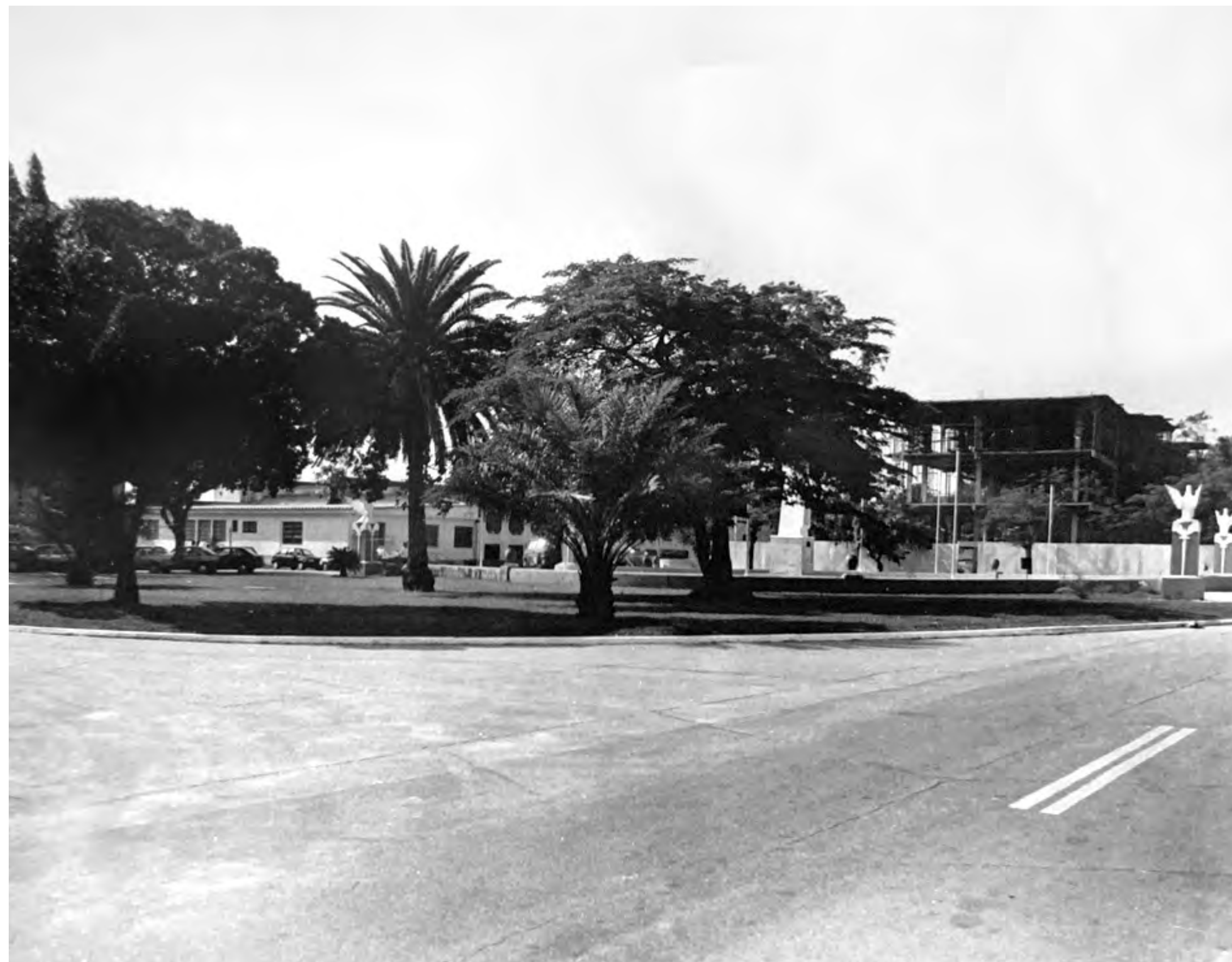
Foto: Construção do prédio do HTO em 1998. Acervo: CMel
