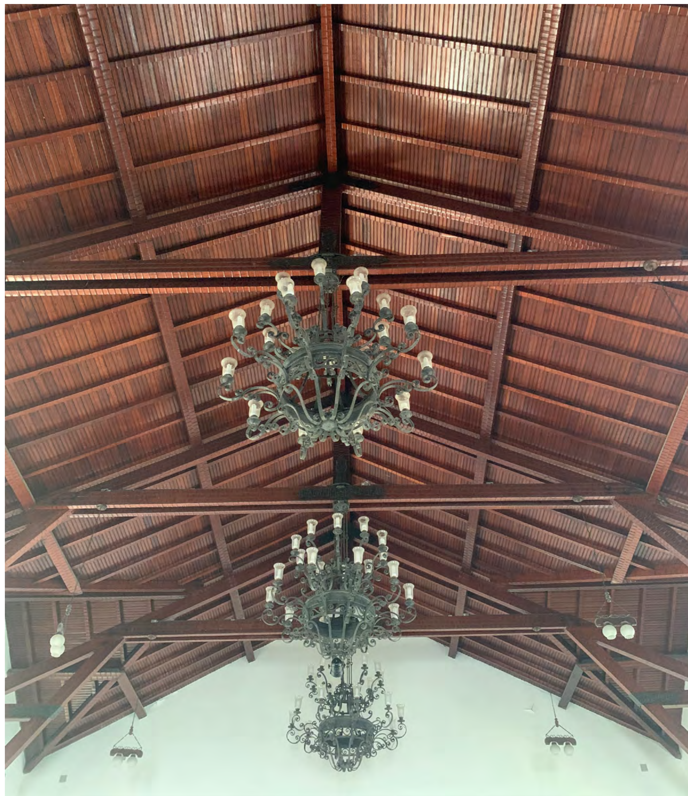
Fotos: interior da Capela N. S. do Loreto com destaque para amarração, em madeira, do telhado estilo Neocolonial, com lustres, piso em mármore com losangos pretos e bancos também de madeira.
