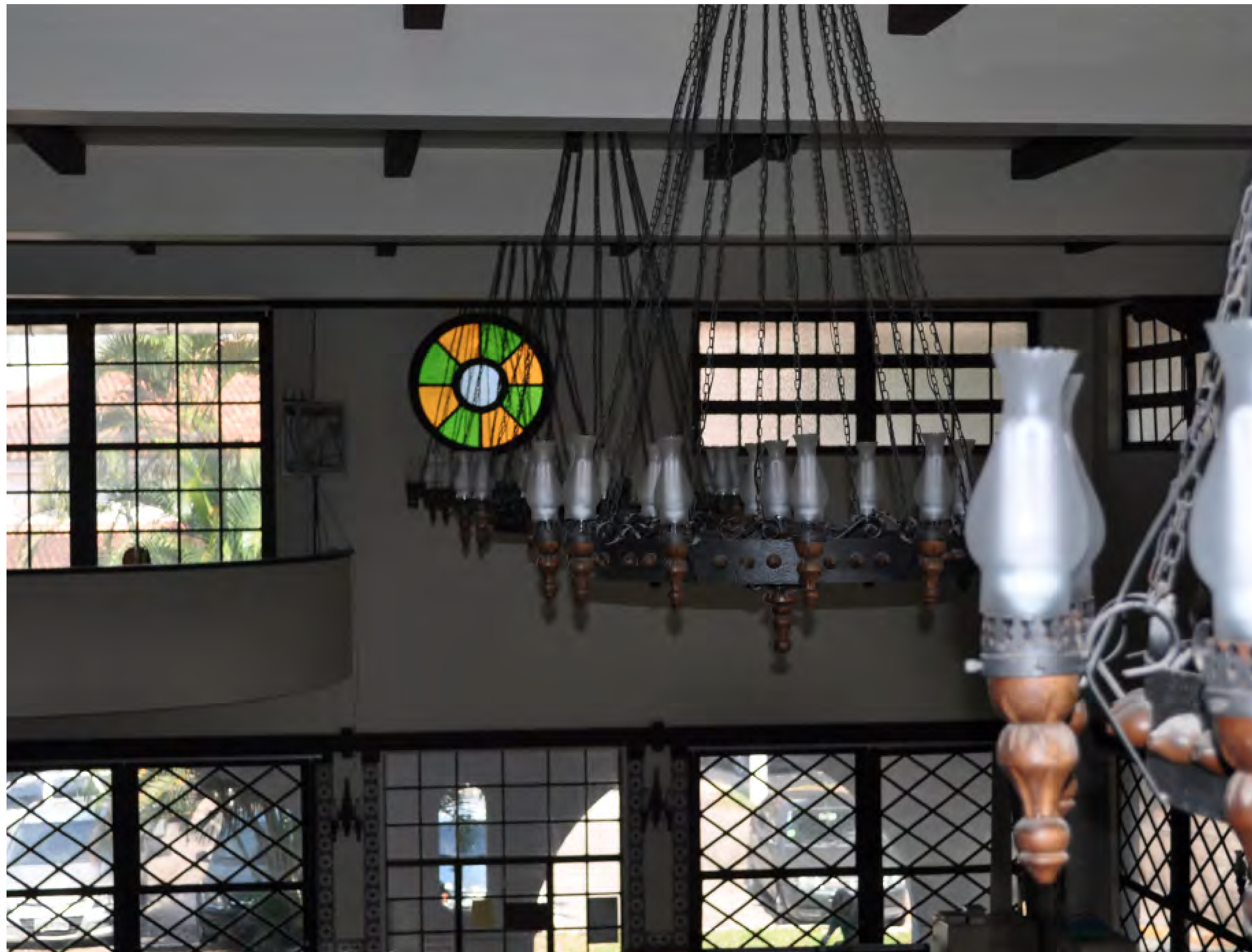
Foto: Detalhes do interior da Biblioteca, Lustres em ferro fundido e madeira, janelas com rótulas, azulejos utilizados como moldura nas janelas do primeiro andar claraboia com vitral. Acervo: CMel
