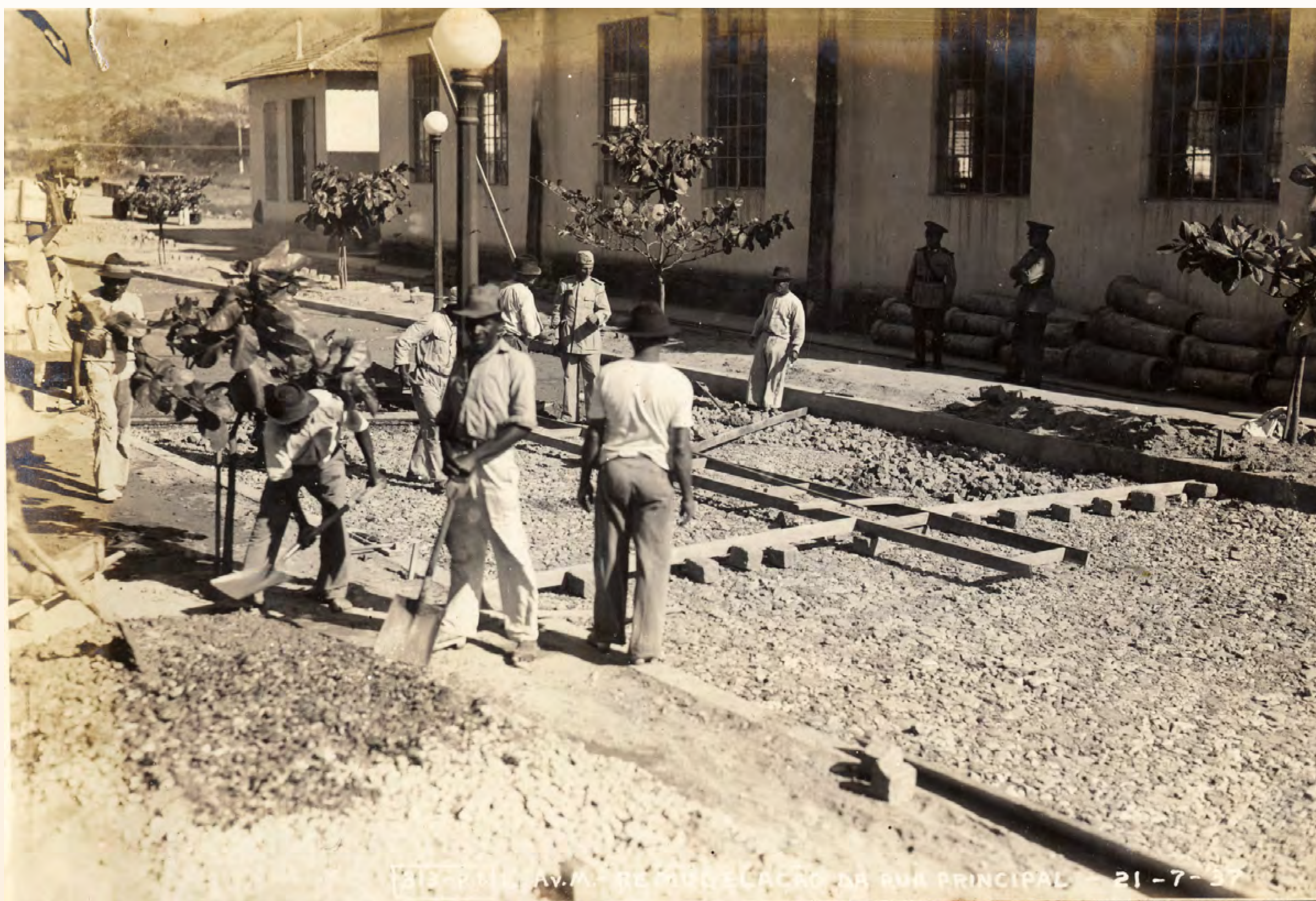
Foto: Operários trabalhando na remodelação da rua principal, antiga Estrada Real de Santa Cruz, em 1938. Fonte: MUSAL
