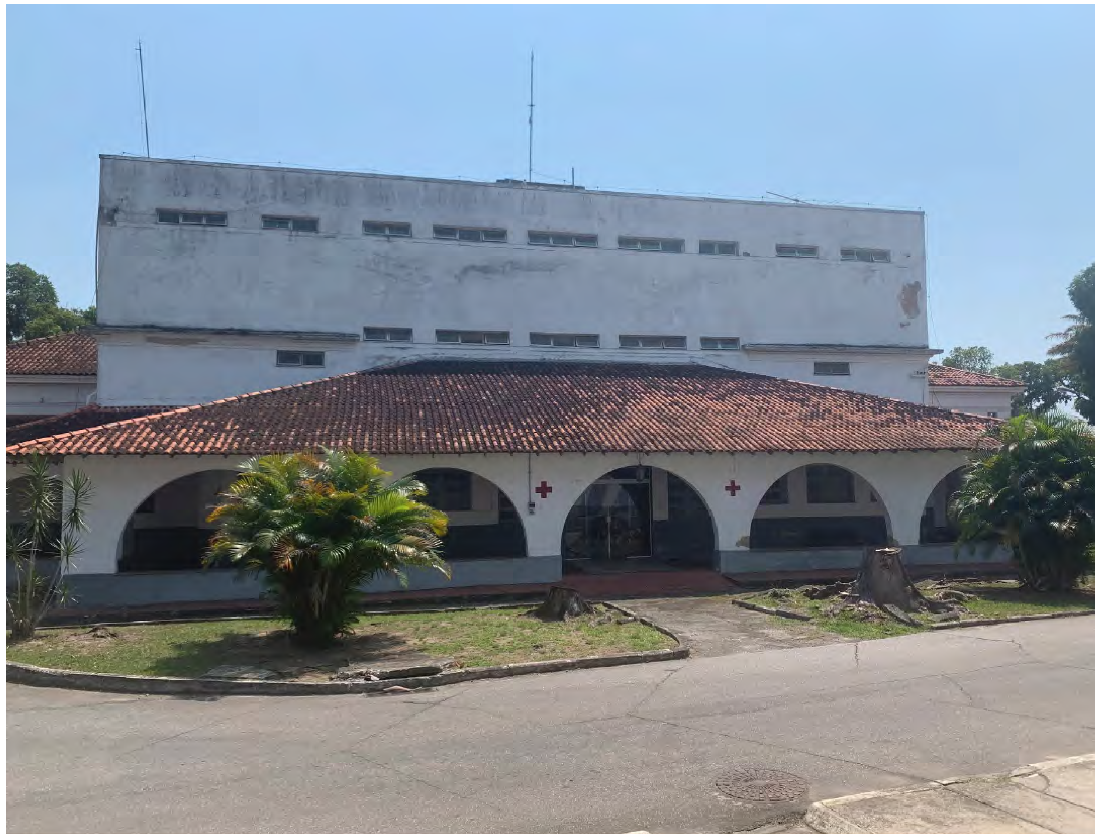
Foto: Vista parcial do antigo posto de saúde do Campo dos Afonsos. Detalhe para as varandas em arco, ao redor do prédio. Acervo: CMeI
