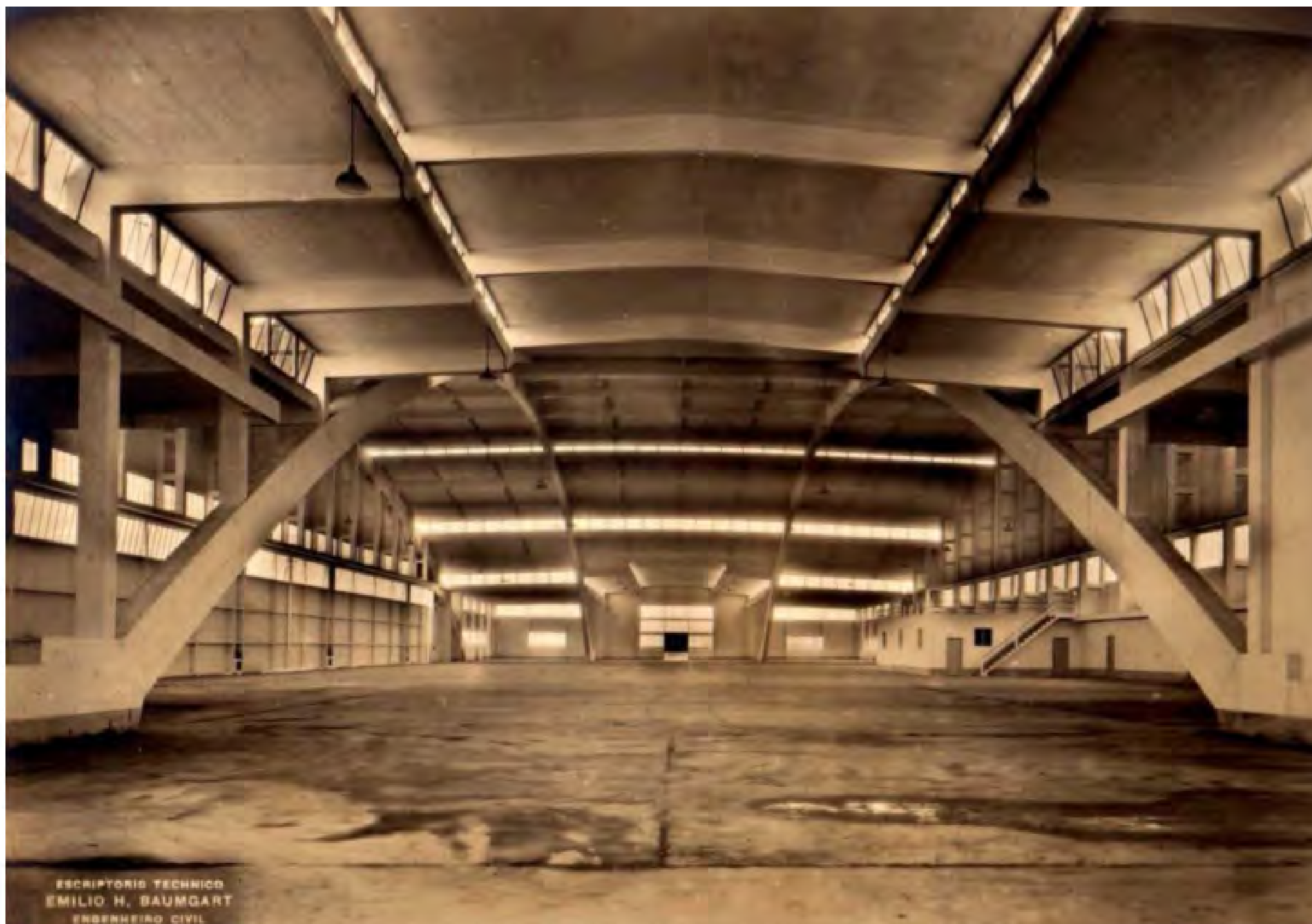
Foto: Visão geral do interior do Hangar "Oficinas Gerais". Detalhe para o vão livre sem colunas e para o teto com suas estruturas em concreto aparente. Fonte: FONSECA, Roger Pamponet da. "Escritório Technico Emílio H. Baumgart": Escola de Concreto Armado e a Arquitetura Modernista Brasileira. Brasília: UNB, 2016.
