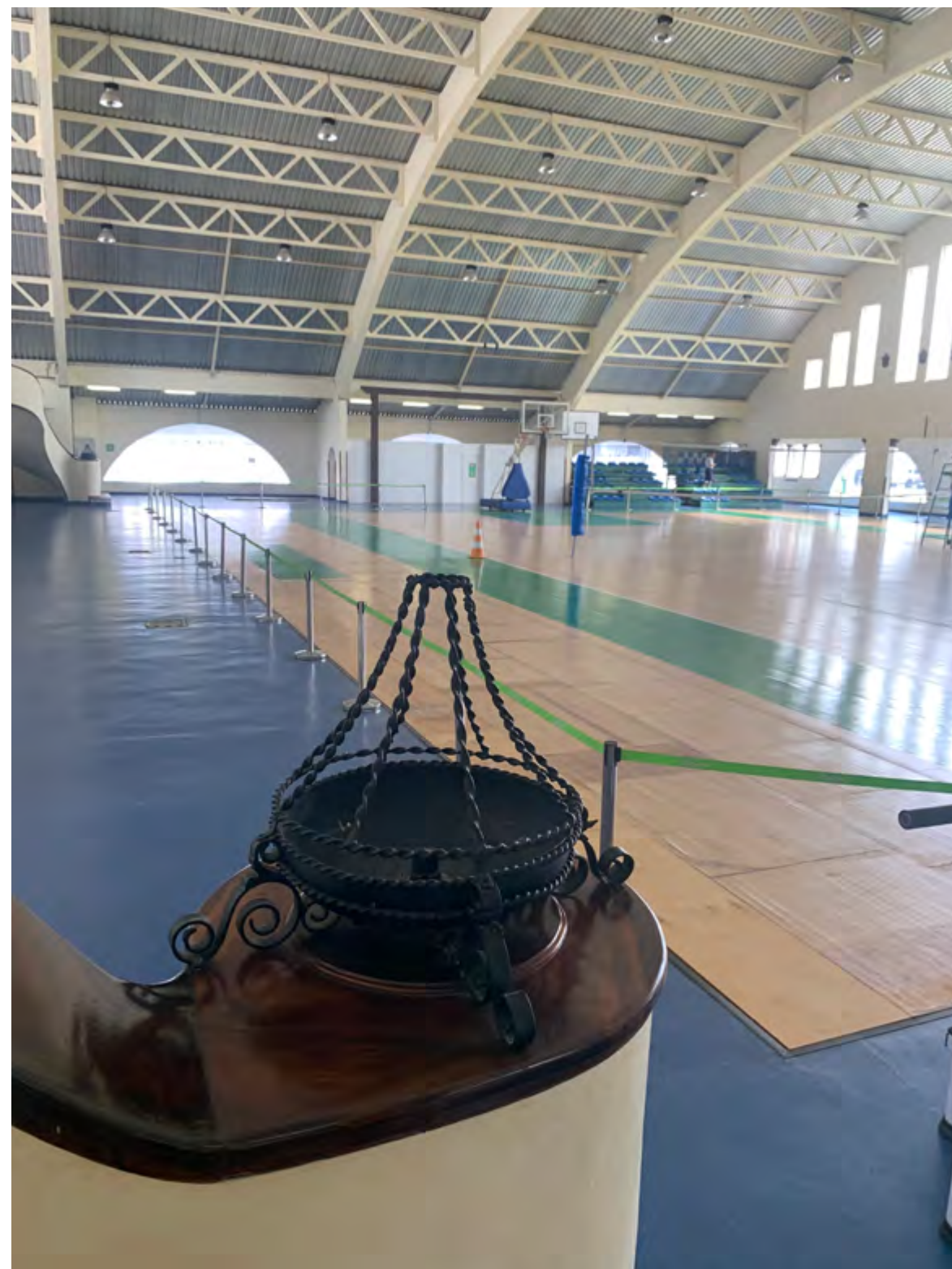
Foto: Bacia em ferro fundido presente no beiral da escada. Fonte: CMel
