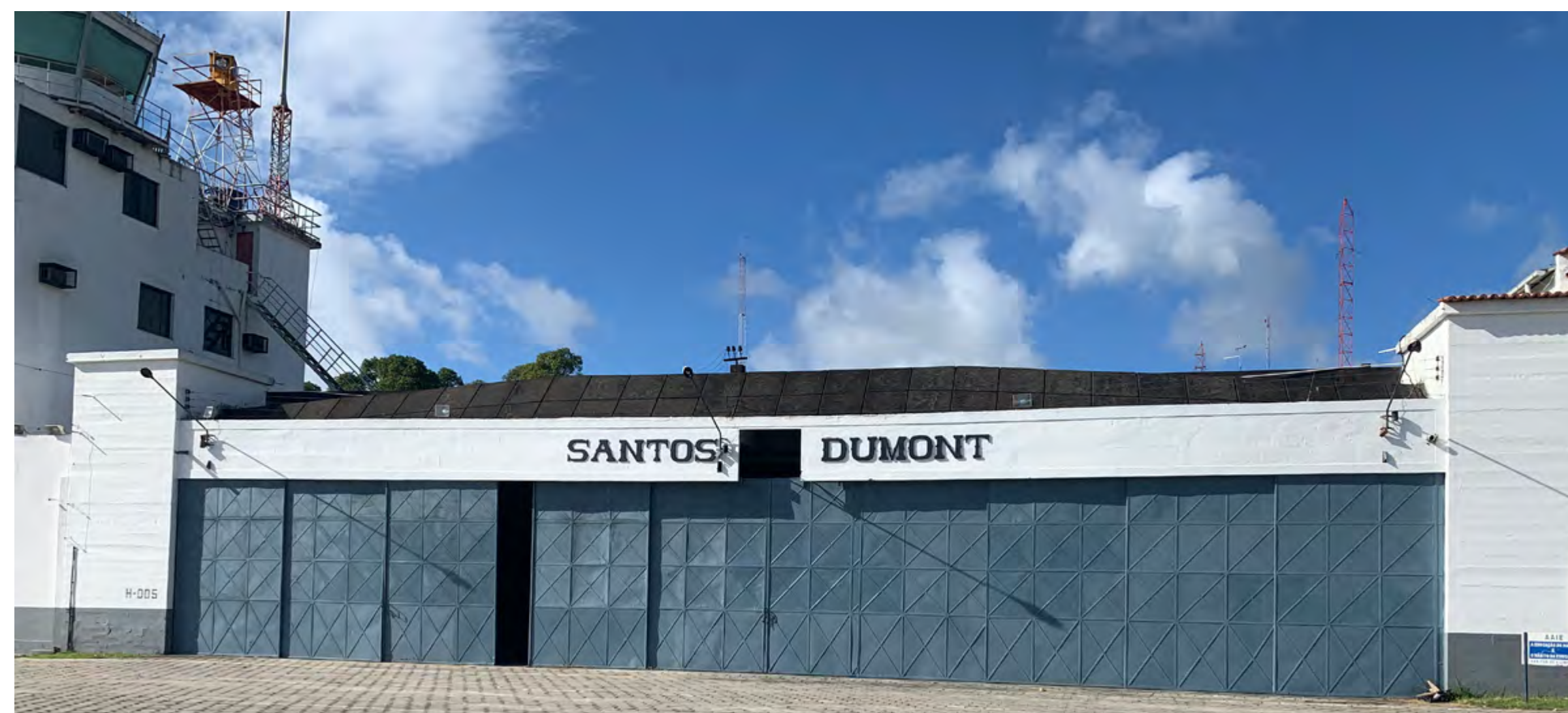
Foto: Frente do Hangar Santos Dumont, construído em 1920, pela Companhia construtora em cimento armado, com altura livre de 4,20m, óculos e caixilhos de ferro com vidros nas laterais e fundos. Fonte: CMel
