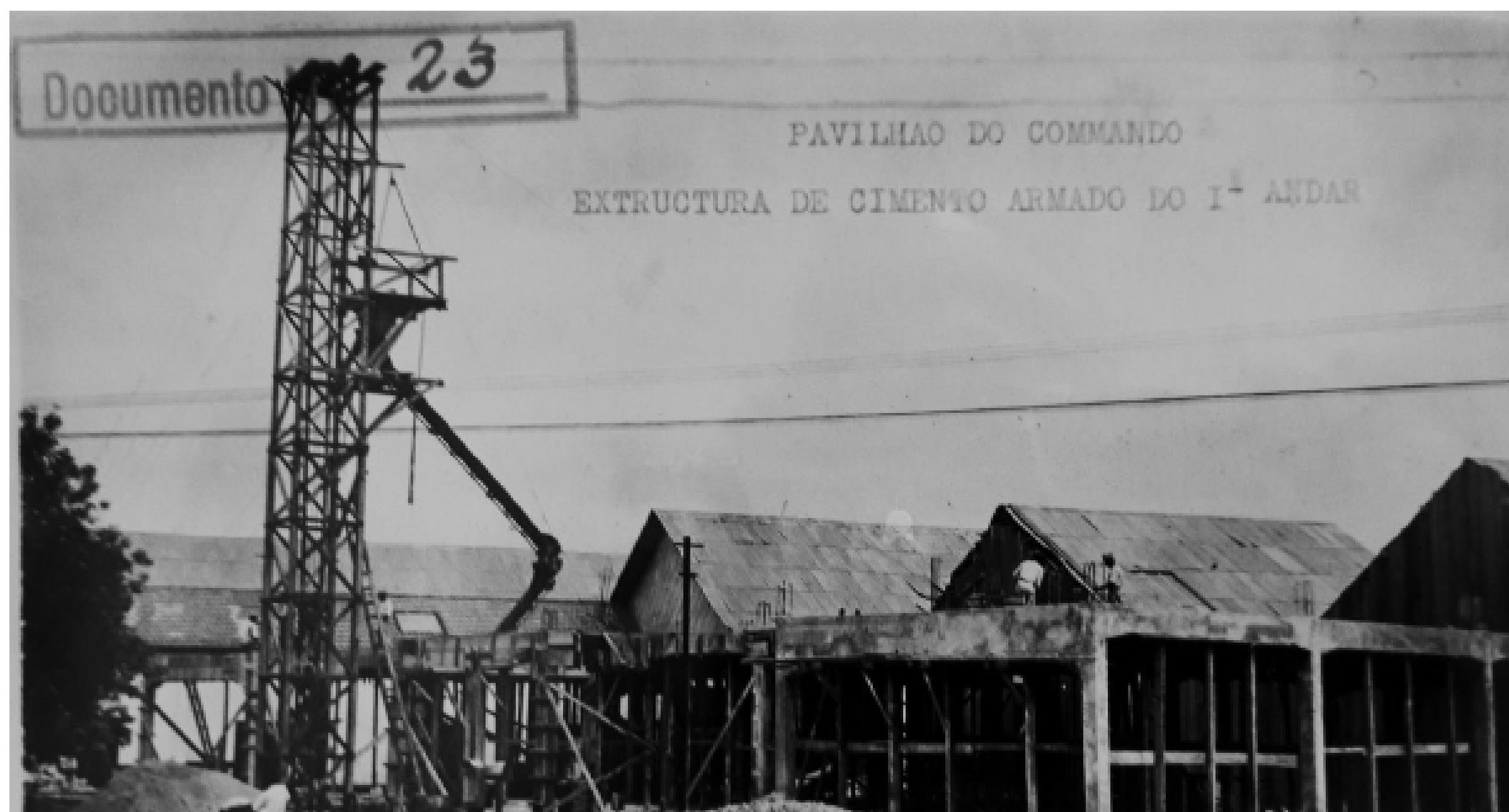
Foto: Demolição dos três primeiros hangares da EBA para construção do Pavilhão do Comando em Cimento Armado, ano 1925. Fonte: AHEx
