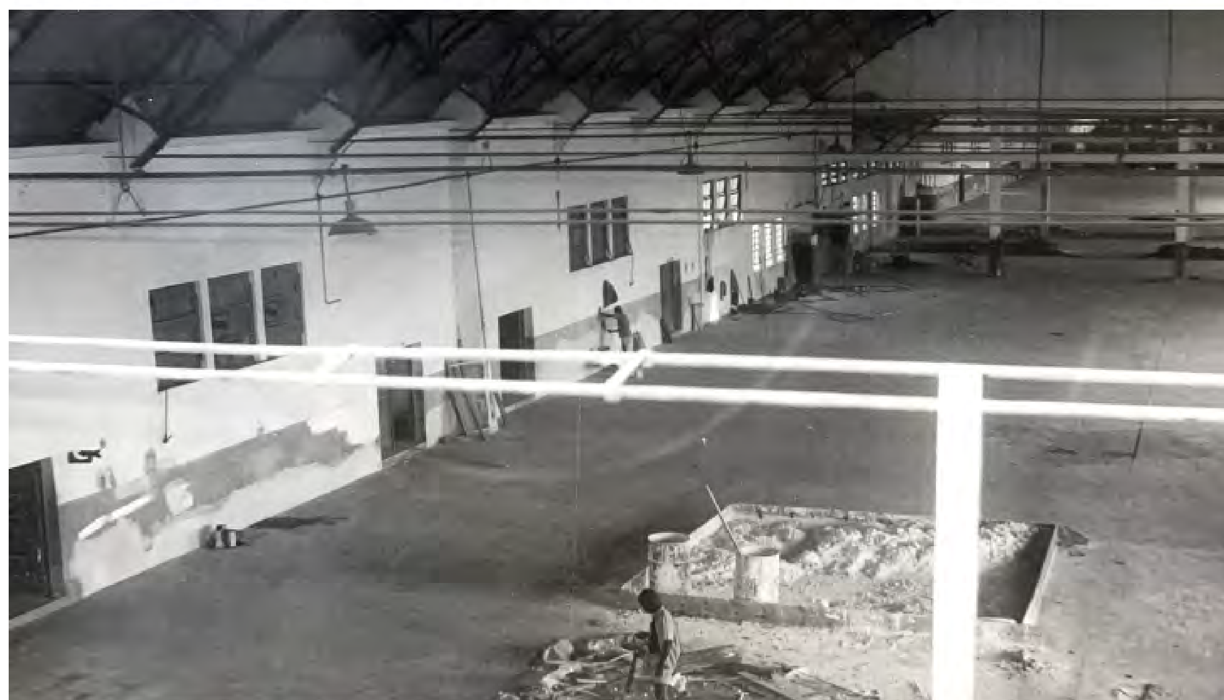
Fotos: Obras no interior dos hangares das futuras instalações do prédio o MUSAL. Detalhe para o telhado, janelas e sinalização nos pisos com pintura. Fonte: CMel
