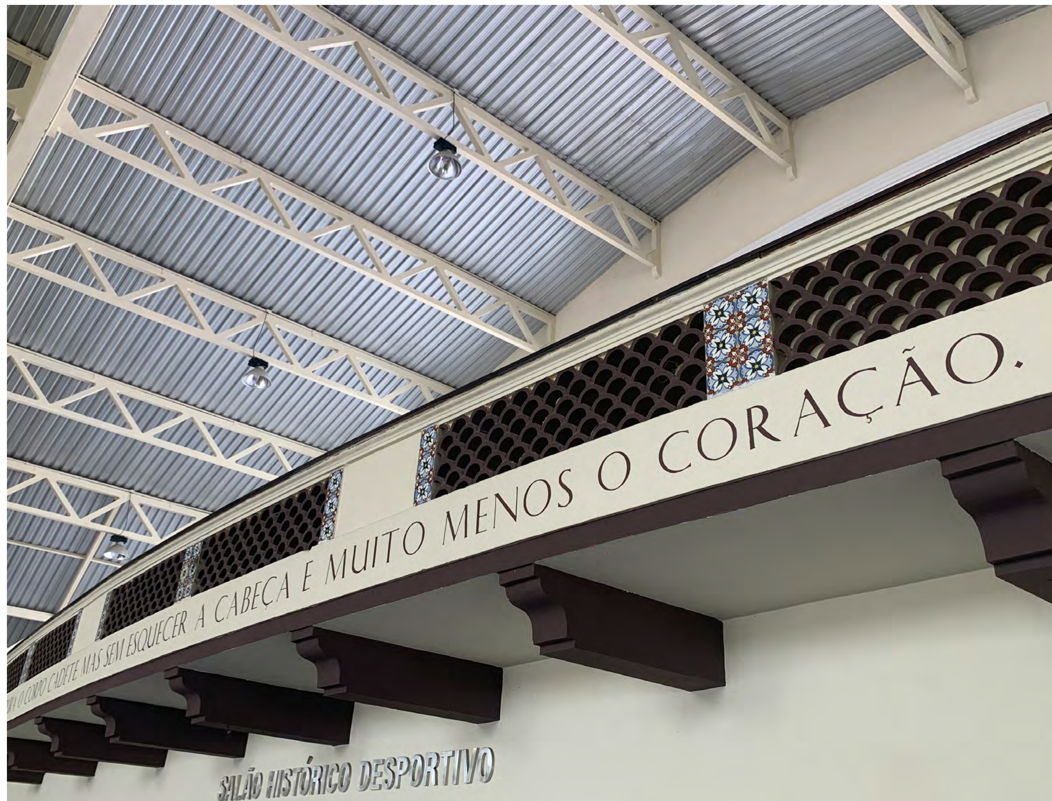
Foto: Detalhe da sacada do Ginásio Brigadeiro do Ar Eduardo Gomes. Estilo neocolonial com rótulas na varanda, vigamento aparente e azulejos ornamentando. Fonte: CMel
