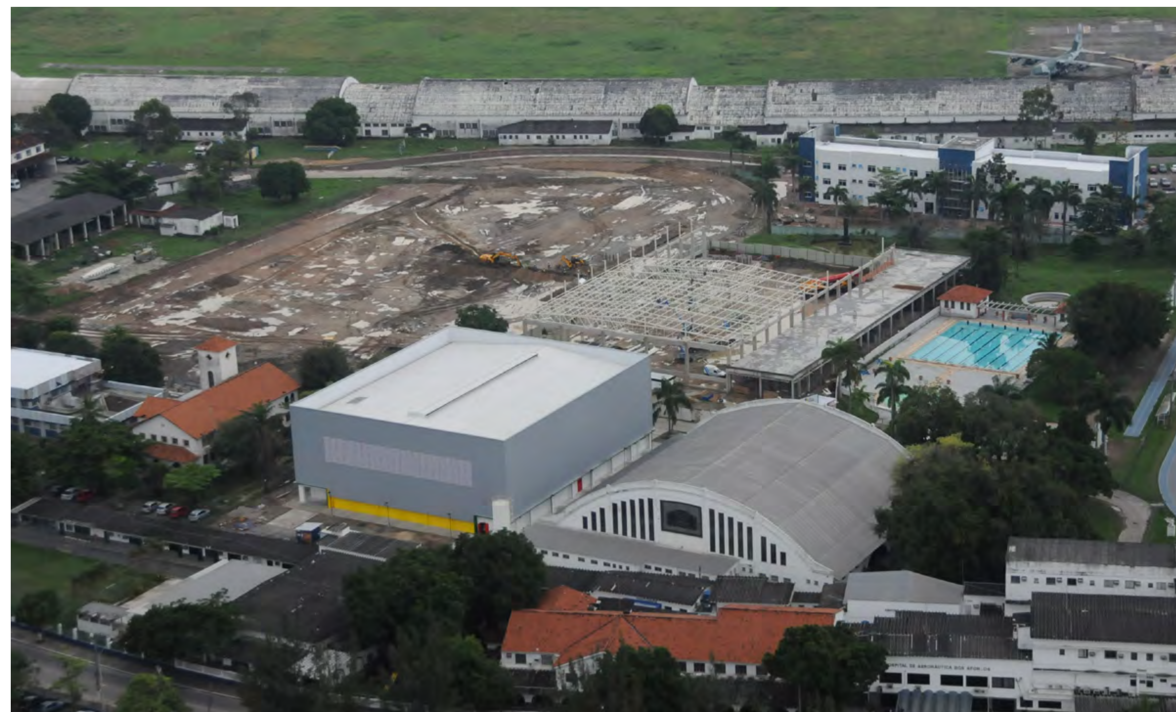
Foto: Vista aérea da construção da nova pista de atletismo. Fonte: CMel
