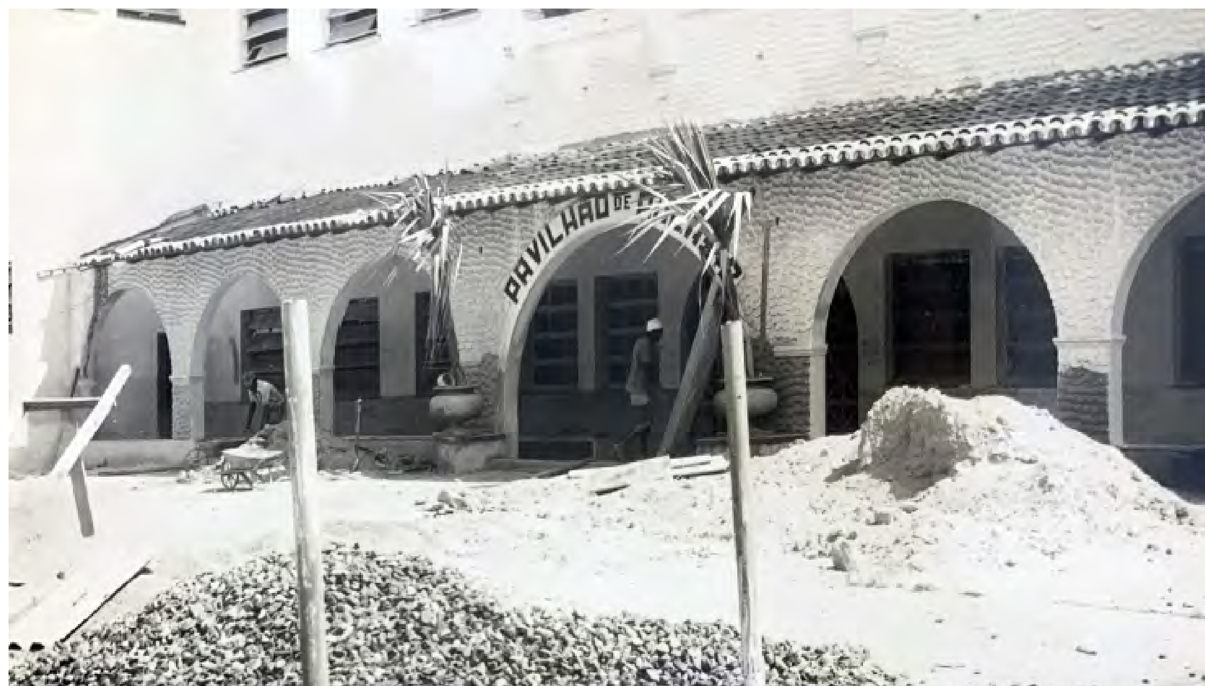
Foto: Registro da década de 1970, de obras na entrada do Pavilhão de aulas, utilizado pela Escola de Aeronáutica. Detalhe para fachada em argamassa rústica, varandas em arco e as ânforas utilizadas para decoração. Fonte: CENDOC
