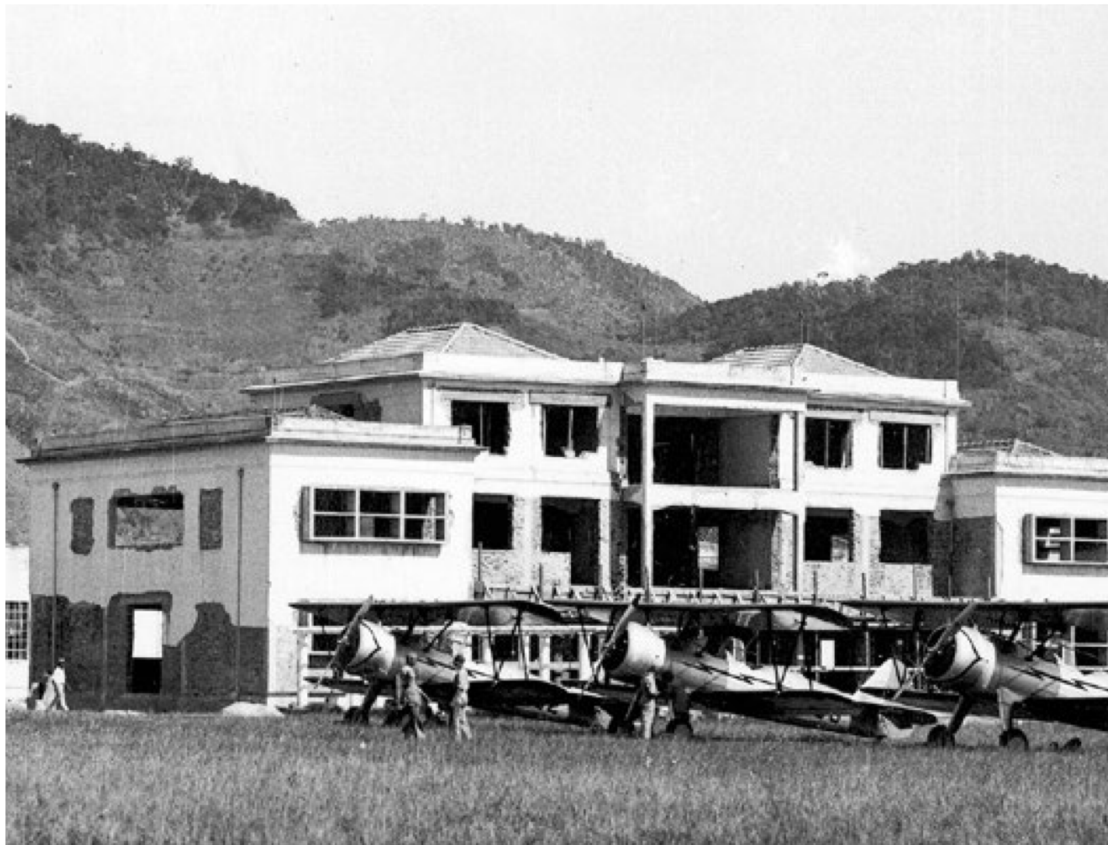
Foto: Remodelação em 1938 do atual prédio do Cassino, detalhe para a construção das janelas em forma de óculos. Fonte: MUSAL
