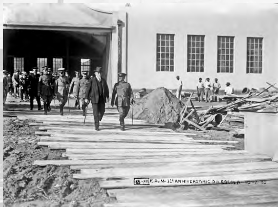
Foto: Visita a construção do Pavilhão de Aerotécnica durante o Aniversário da Escola de Aviação Militar. Fonte: MUSAL
