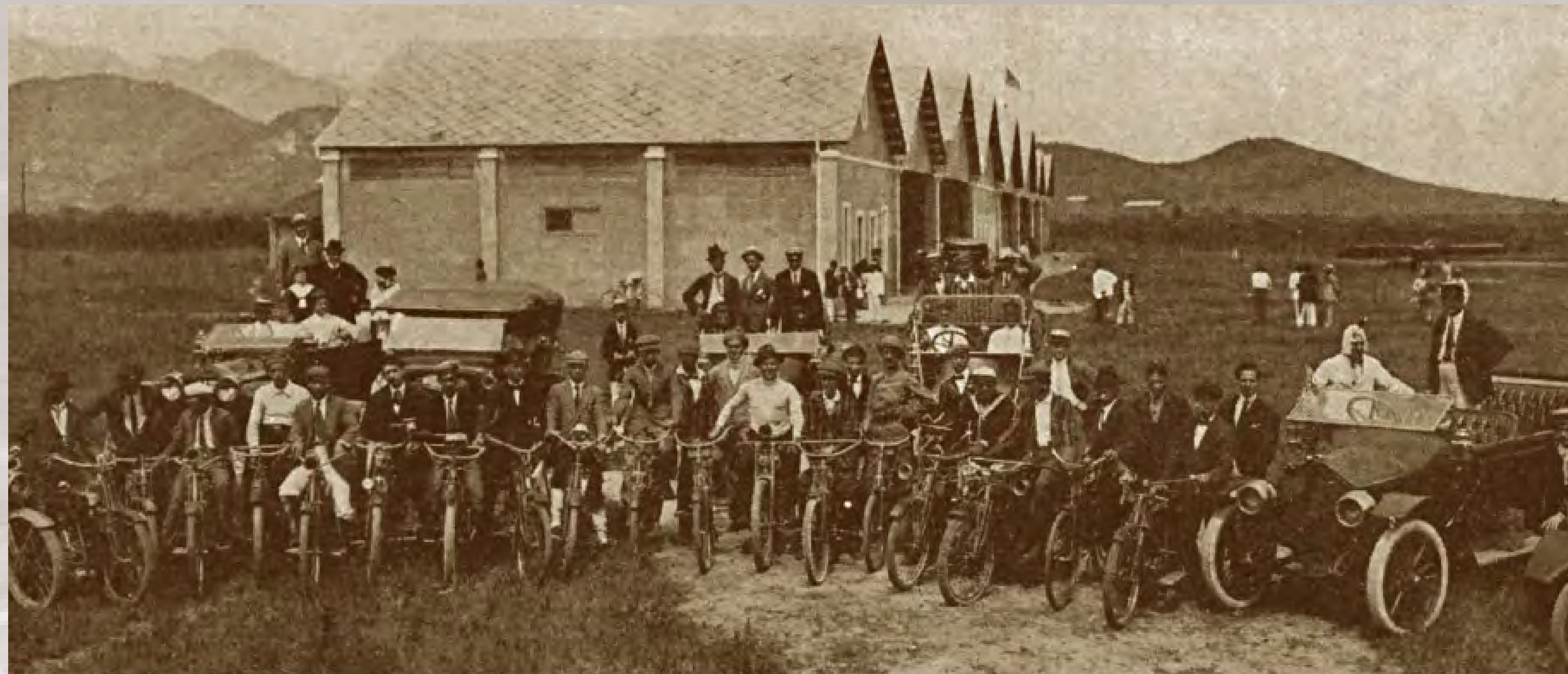
Foto: Visita do club de motociclistas nas oficinas da EBA no Campo dos Afonsos. Detalhe para o telhado com telhas impermeáveis Fonte: Revista Careta
