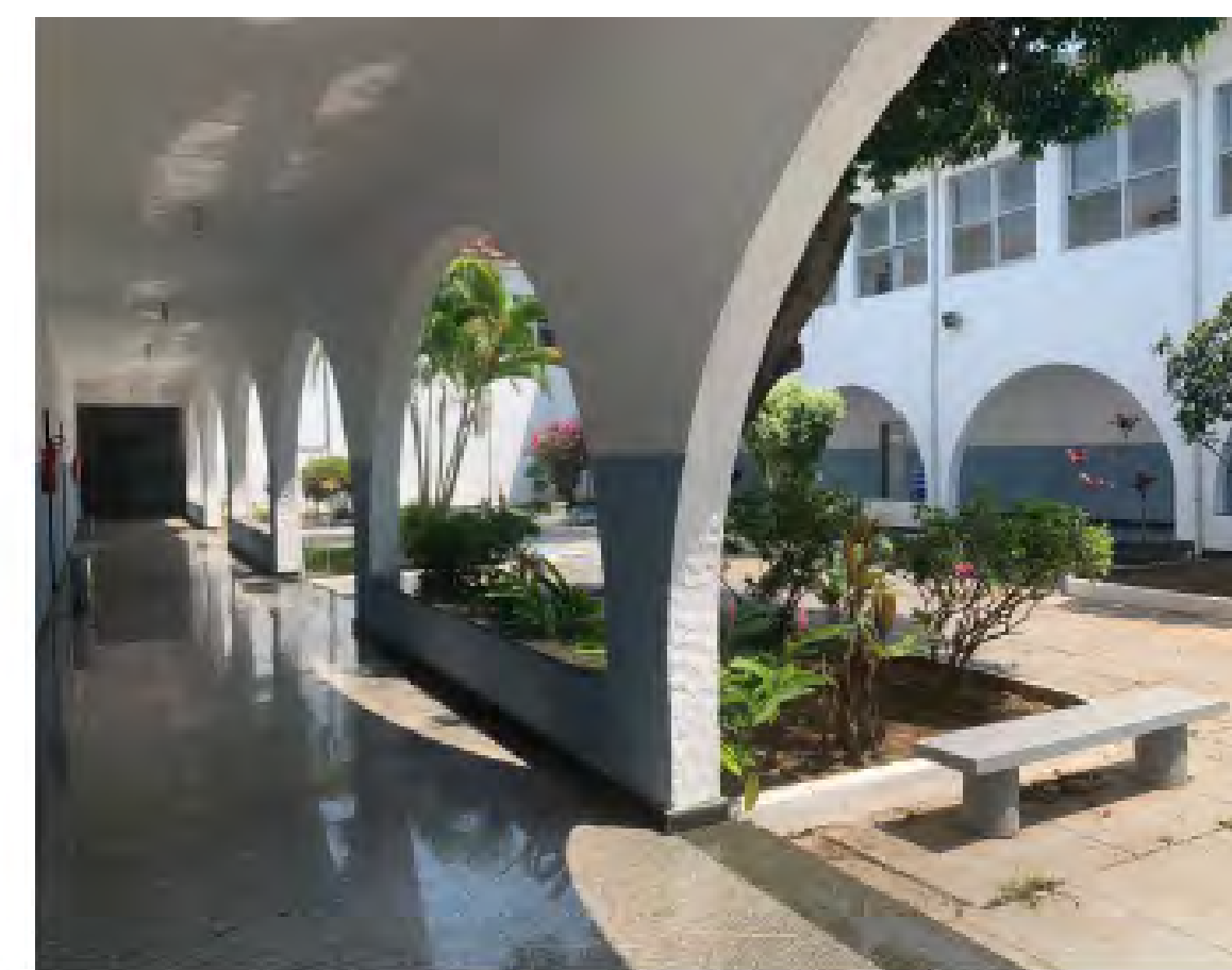
Fotos: Jardim de inverno da edificação. Ainda pode ser observado os símbolos e as referências do CIEAR. Detalhe para as varandas ao redor em arco. Acervo: CMel
