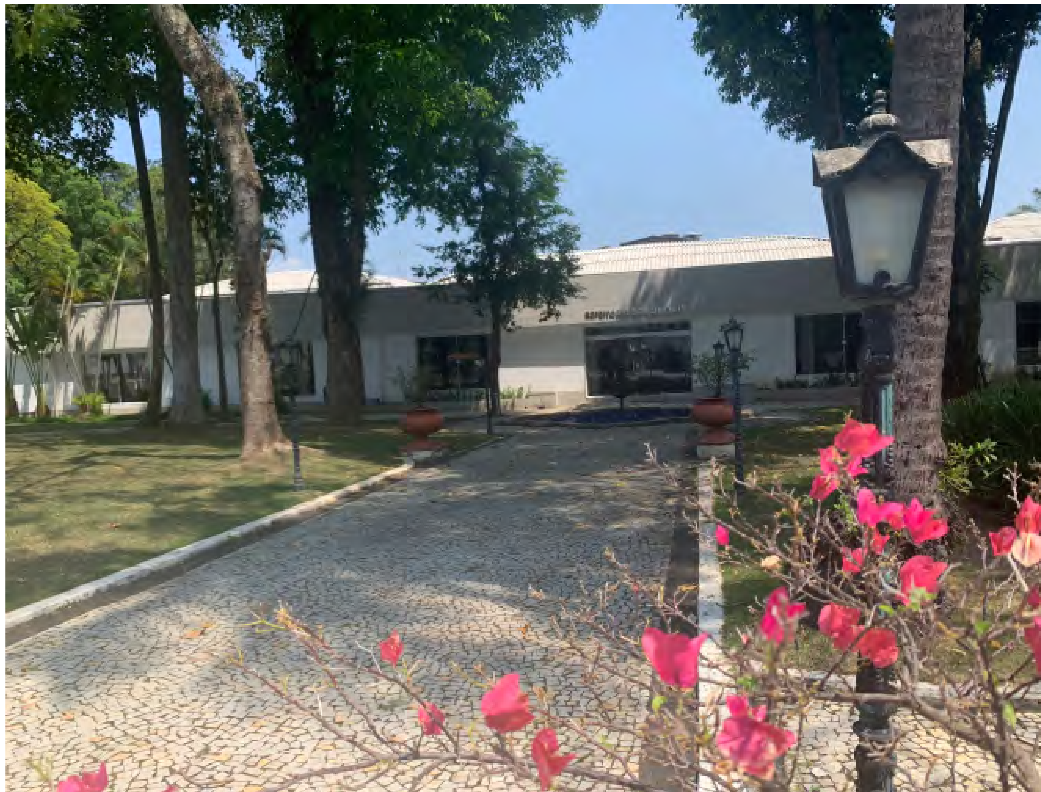
Foto: Registro de 2021 da nova fachada do rancho após reforma de 2020. Acervo: CMel
