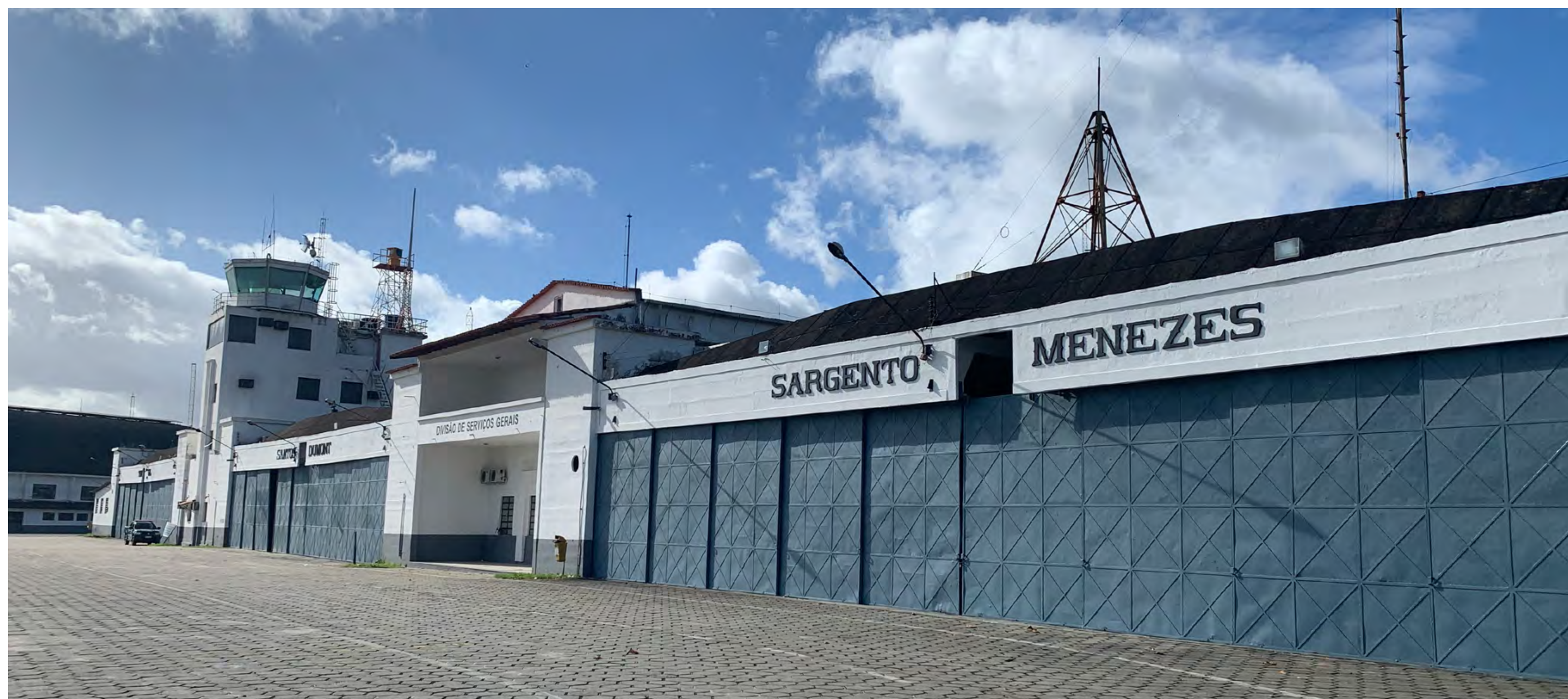
Foto: Frente dos hangares Sargento Menezes, Santos Dumont e Tenente Gil, construídos em 1920 pela Companhia construtora em cimento armado, com altura livre de 4,20m, possuem características Art Déco, com fachadas simétricas, faixas paralelas, em alto relevo, verticais e em seu interior janelas basculantes em forma de óculos com caixilhos de vidro. Fonte: CMel
