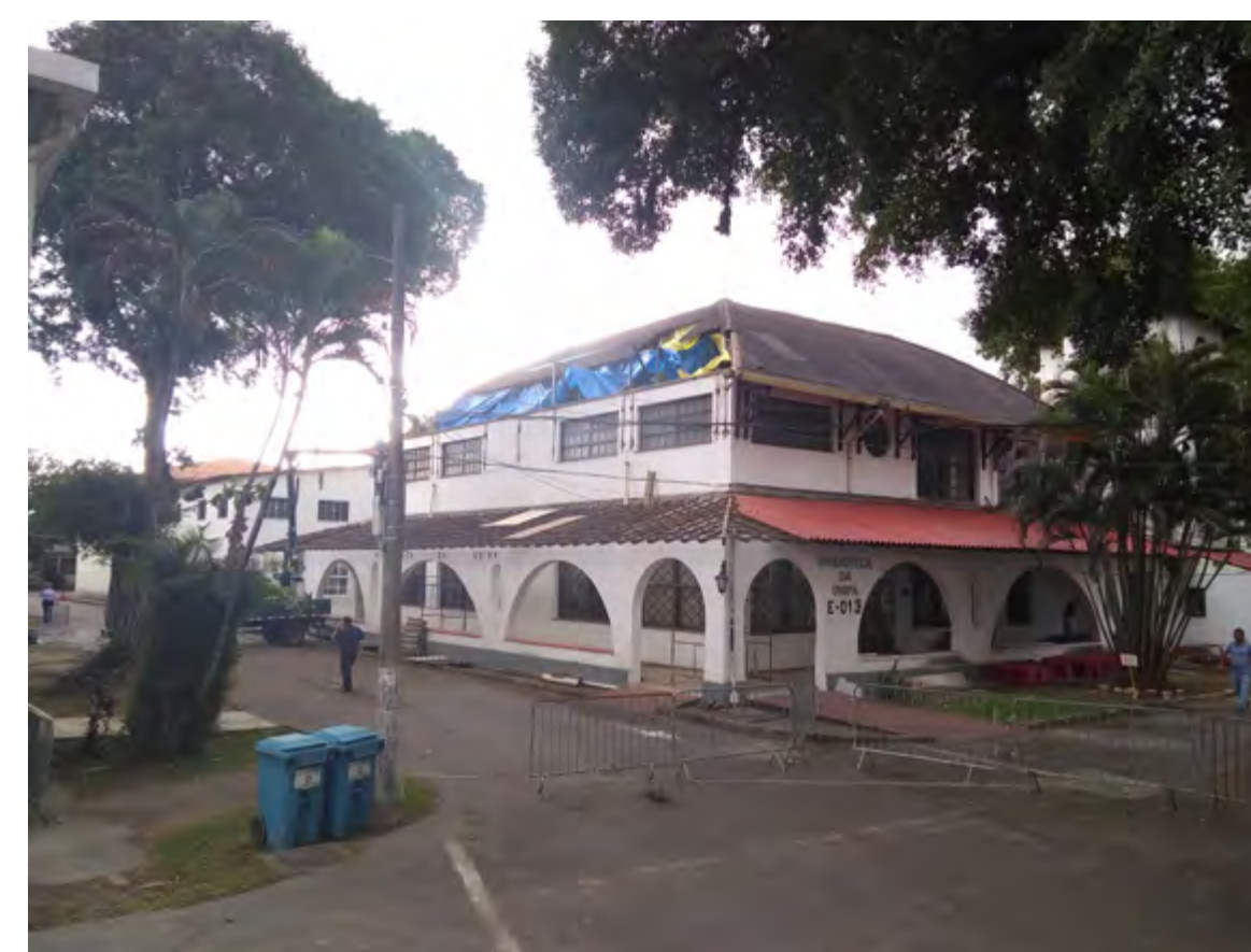
Fotos: Registros da reforma e remodelação da Biblioteca em 2019. Detalhe para a retirada do telhado original e construção do novo. Acervo: CMel
